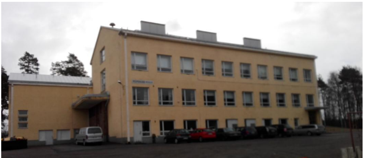
Kuva 41. Vasemmalla liikunta-/ juhlasaliisiipi, korkean osan päädysssä pääsisäänkäynti
