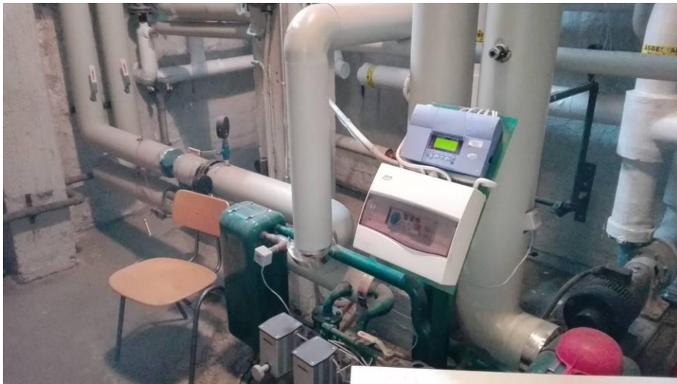
Kuva 13. Kaukolämpölaitteisto on asennettu v. 2000
