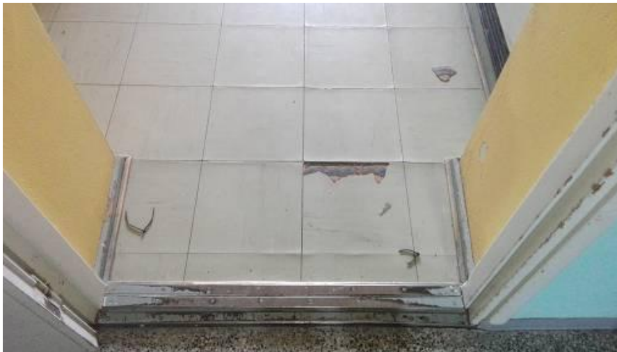
Kuva 24. Luokan kulunut kynnyks ja lattia
