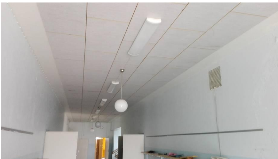
Kuva 23. Käytävien valaistusta on parannettu
