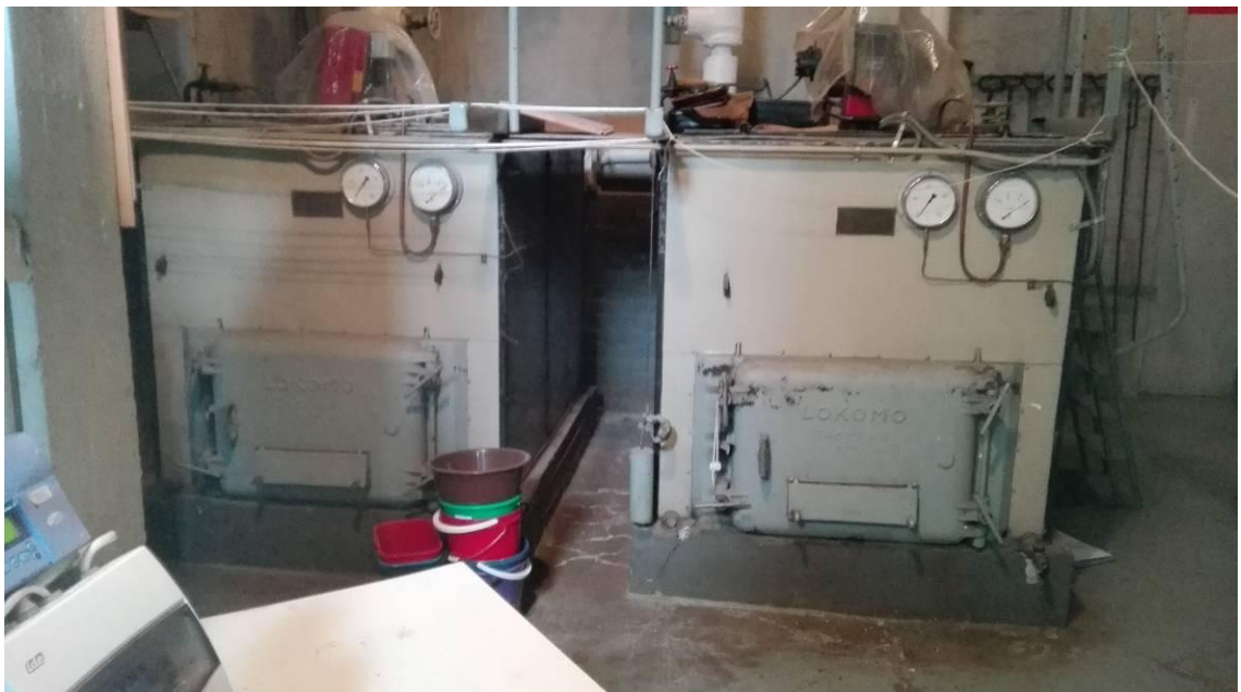
Kuva 12. Vanhat vesilämmityskattilat
