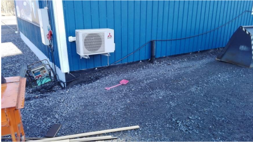
Kuva 82. Maanpinta on noussut uuden teollisuushallin rakentamisen vuoksi (kuvat 82-83)
