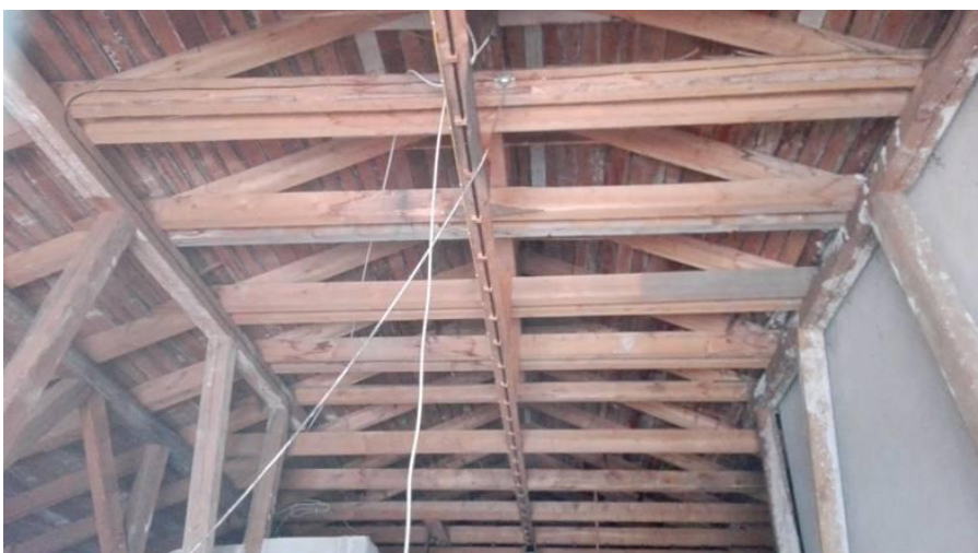
Kuva 37. Vesikattorakenteita kuvattuna ullakolta
