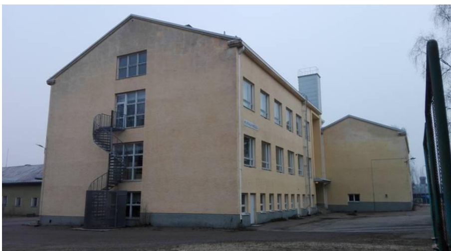
Kuva 39. Rakennuksessa on lyhyet räystäät.
