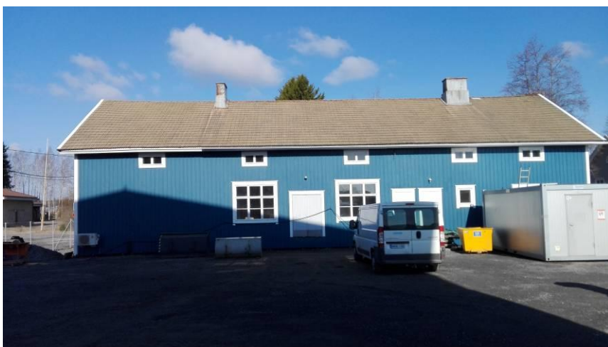
Kuva 84. Pihan puoleinen julkisivu
