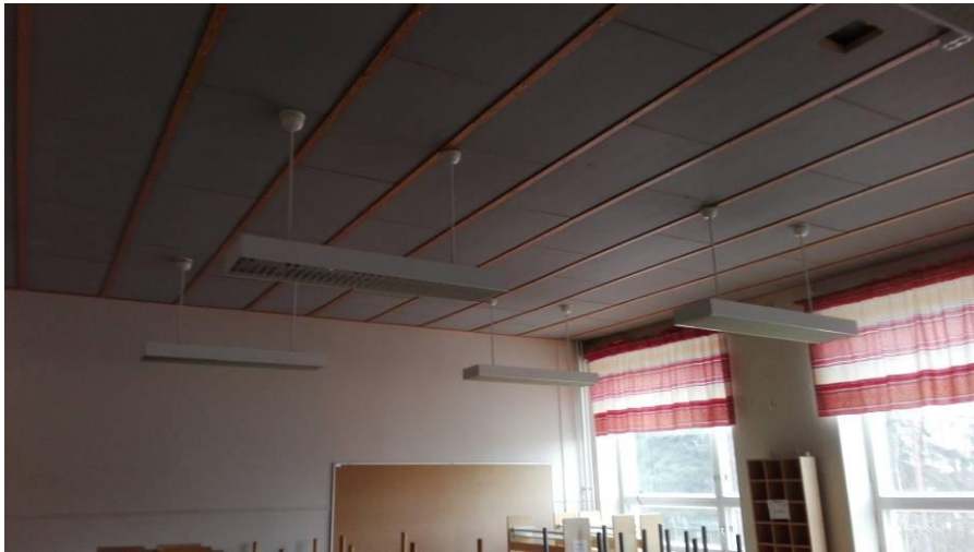
Kuva 22. Luokkien katot on levytetty akustiikkalevyllä
