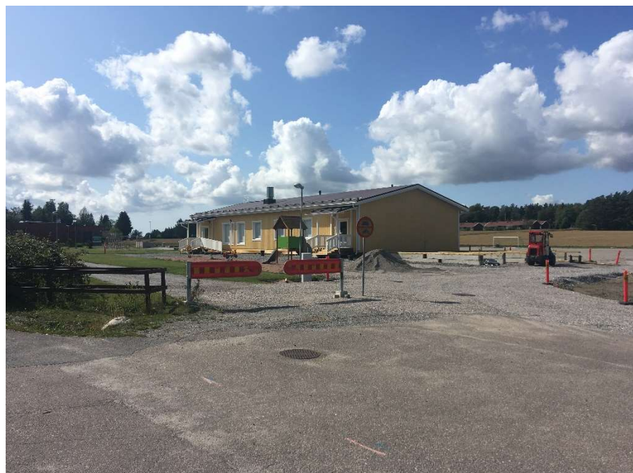
Uusi päiväkoti kuvattuna kaakosta. Kuva Pasi Lappalainen
