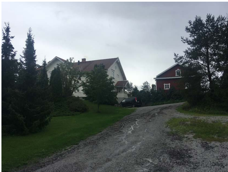
Asuinrakennus kiinteistöllä 538-428-8-62 Pappila. Kuva: Pasi Lappalainen
