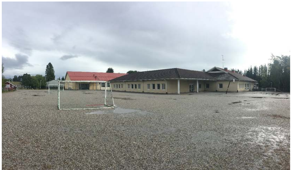
Nummen koulurakennus ja hiekkakenttä. Kuva: Pasi Lappalainen
