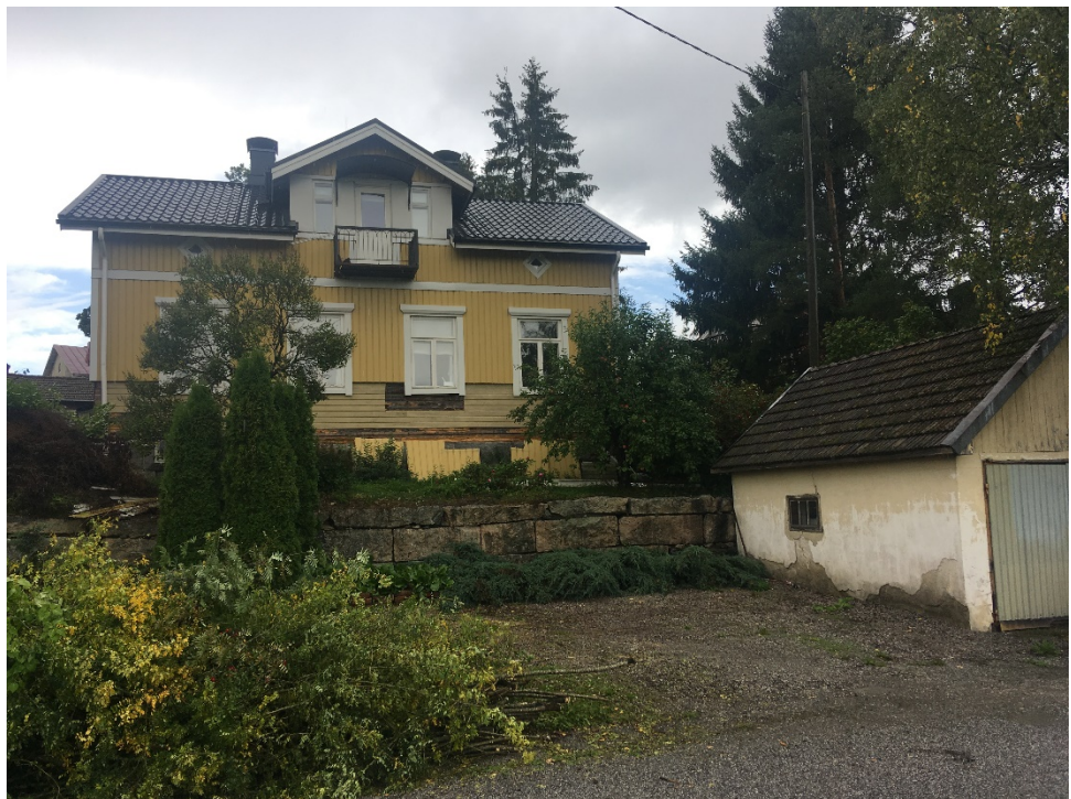
Kaavalla suojeltavaksi osoitettava Kallipään torppa kiinteistöllä 538-428-3-7 Kal- lipää. Kuva: Pasi Lappalainen
