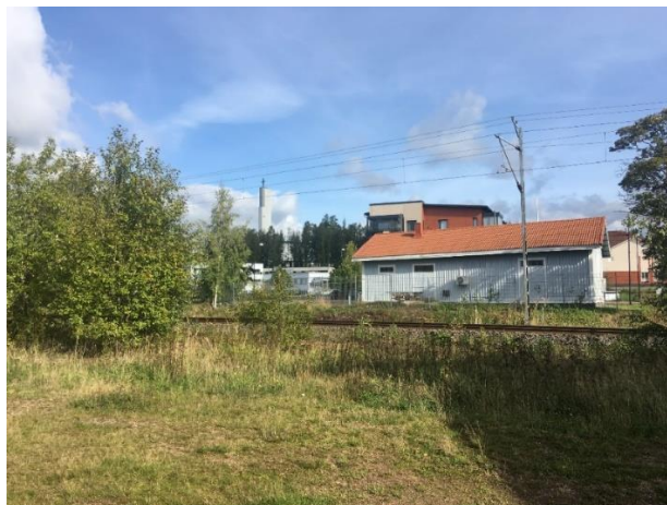
Rautatieaseman viereinen rakennus suunnittelualueella. Taustalla asuinkerrostalo ja Nakkilan kirkon torni.
