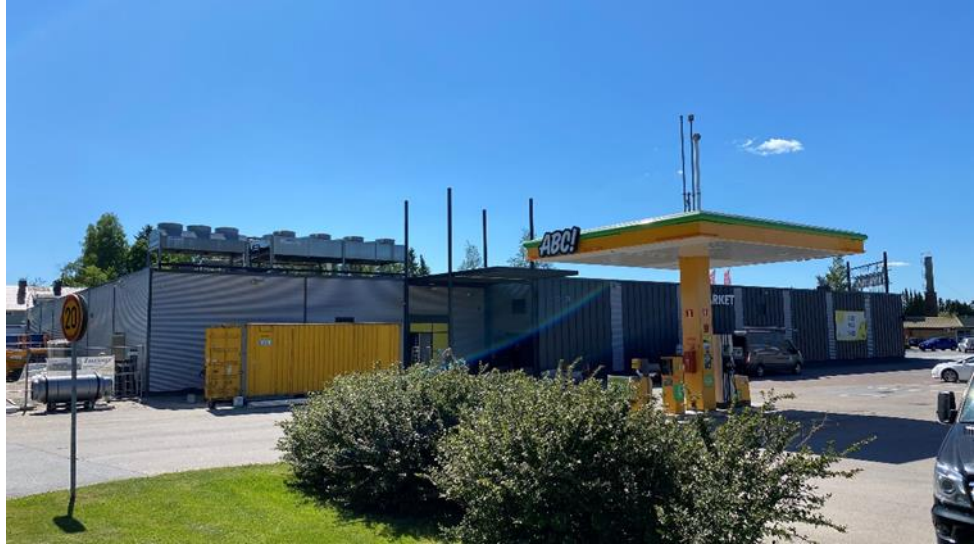
Liikerakennusten korttelialueella sijaitsee mm. S-market ja ABC polttoaineasema. Kuva koillisesta.
