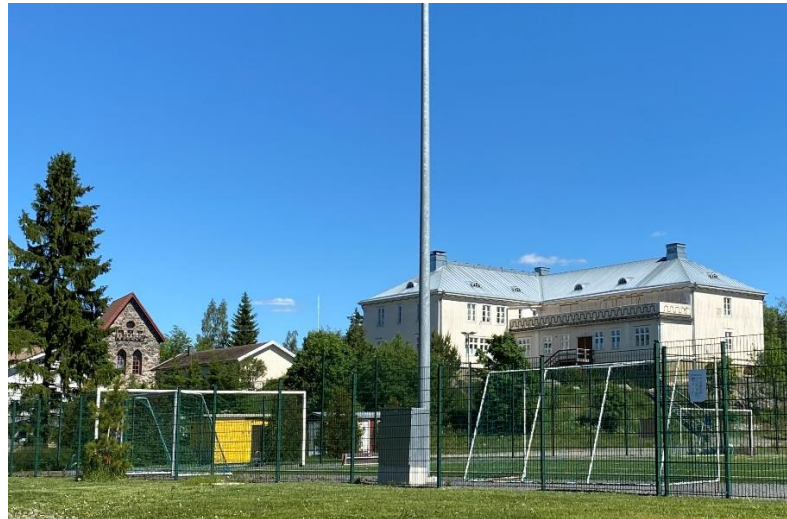
Kokemäen Seuratalo ja kivinen muuntamorakennus Ruonanpäntien itäpuolella.
