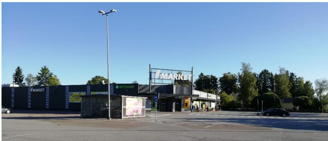
Kuvassa uusittu S-market. Aluelämpökeskuksen piippu S-logon takana.
