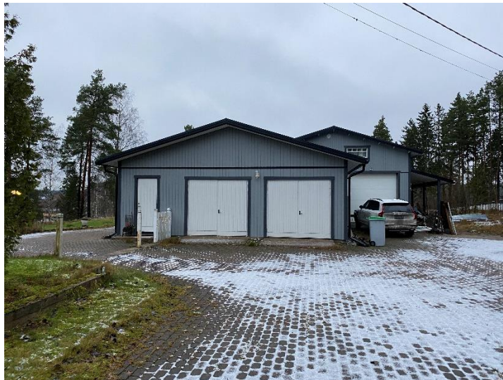
Talousrakennus kiinteistöllä 738-510-1-19 MUUMIMÄKI.
