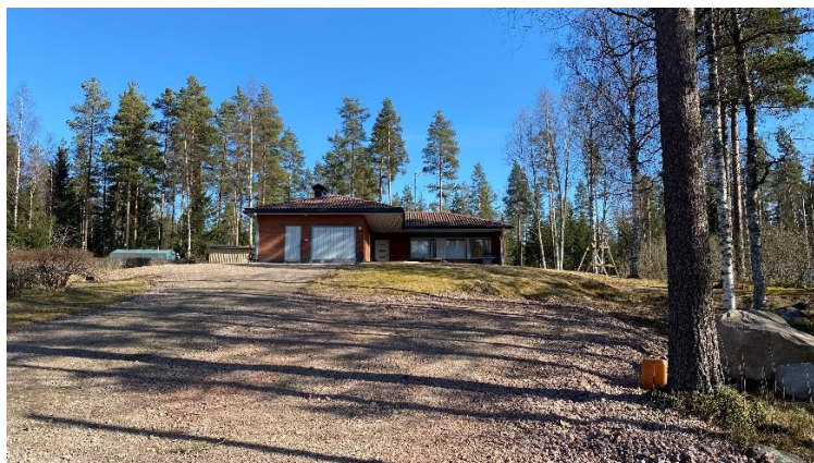
Asuinrakennus kiinteistöllä 581-421-5-247 MÄNTYRINNE.
