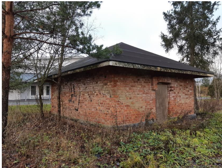
Tiilinen rakennus suunnittelualueen itäosassa.
