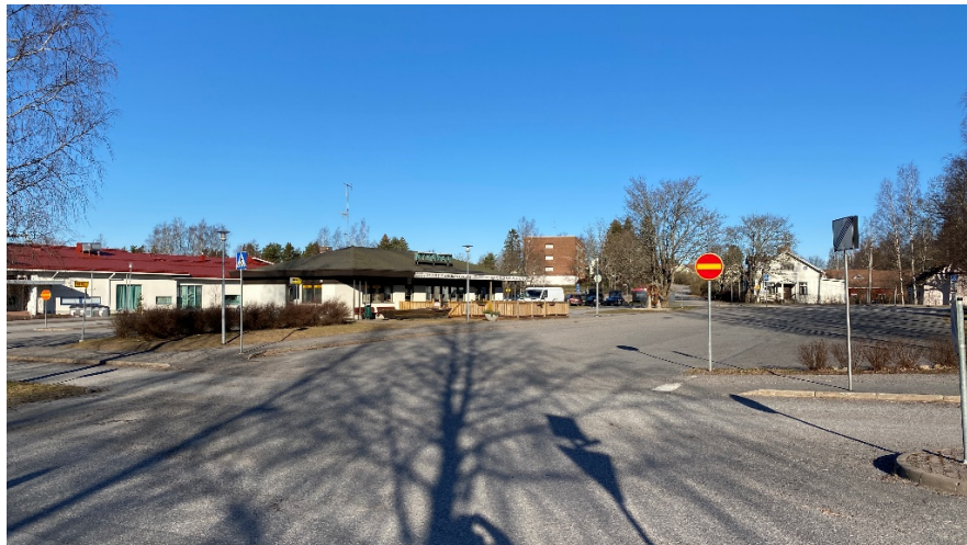
Päiväkoti ja linja-autoasema. Kuva kaakosta.
