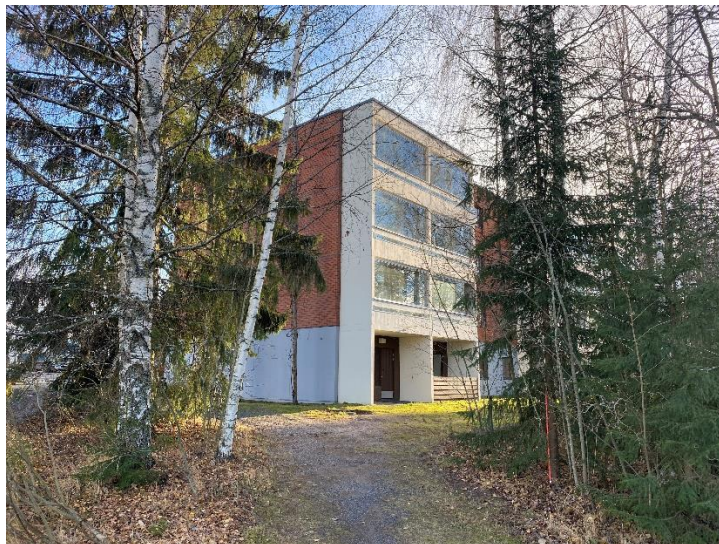
Asuinkerrostalo Vanhan Tampereentien pohjoispuolella.
