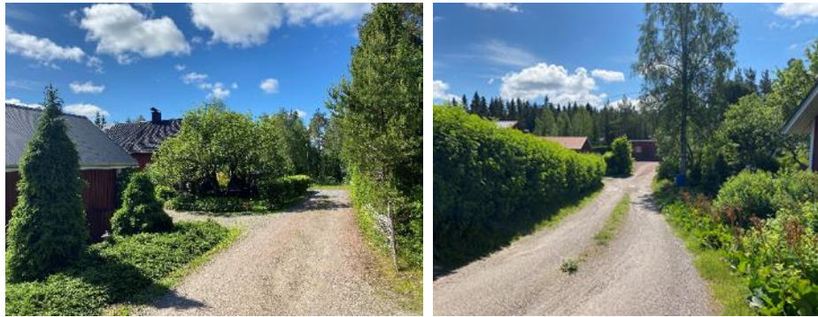
Kuva Raitalantieltä kohti itää. Kuvassa suunnittelualueella kulkeva sähkölinja.
