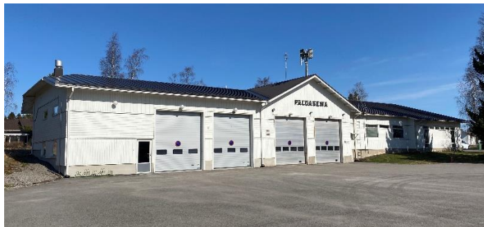
Kirjasto/paloasema etelästä kuvattuna.
