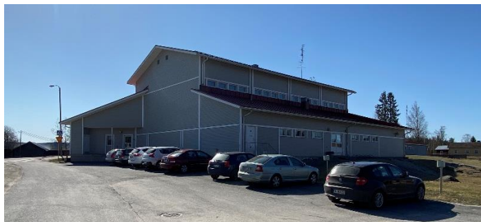
Koulurakennus koillisesta Valontieltä kuvattuna.
