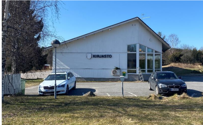
Kirjasto/paloasemarakennus kuvattuna koillisesta.
