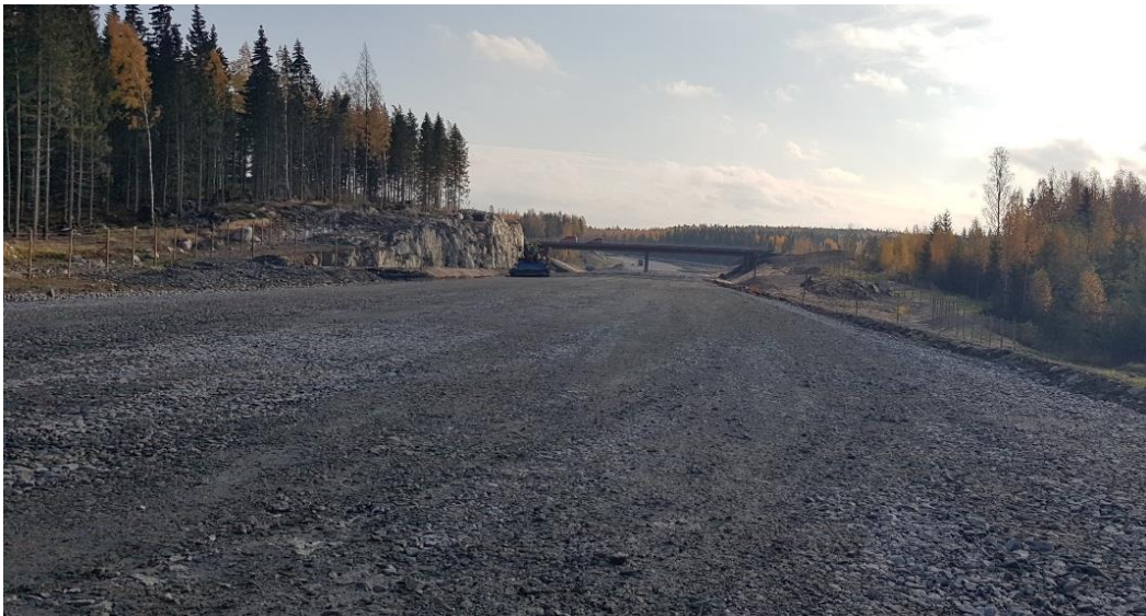
Kuva 4. Inventoitavan alueen länsiosaan oli tehty uuden ohitustien perustus. Kuvattu luoteesta. Kuva: Sinikka Kärkkäinen.
