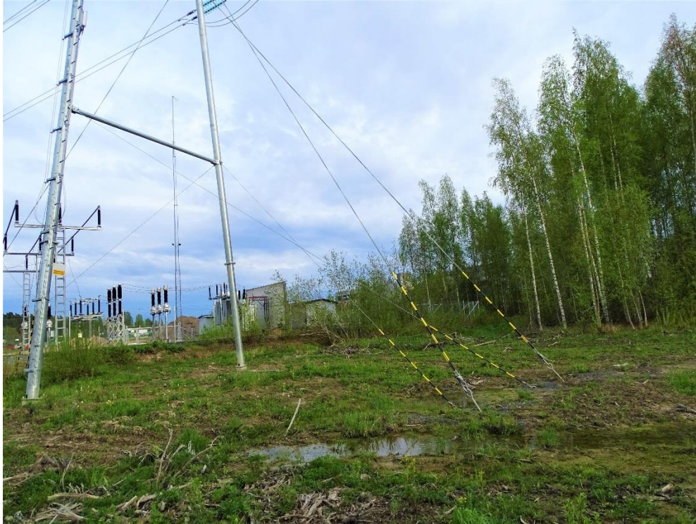
Kuva 6. Kuviolla 3 sijaitseva voimajohto sekä muuntamorakennus taustalla. Kuvaussuunta lännestä.
