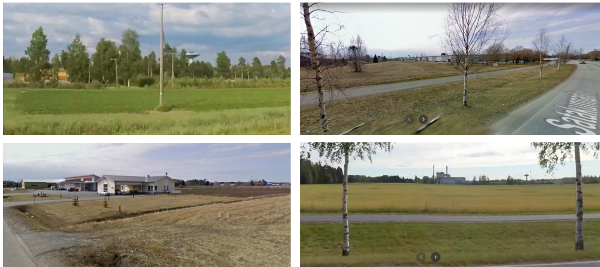
Kuva 6. Kuvasarja katunäkymistä kaava-alueen suuntaan. Peipohjan vesitorni näkyy paikoin alueen tieverkostolta maamerkinä. Ylävasen VT2:lta katsastusaseman kohdalta, yläoikea Satakunnantieltä Sinituote oikeassa reunassa, alavasen Teljänportilta Kokemäen taksikeskuksen kohdalta, alaoikea Satakunnantieltä Kokemäen Lämmön kohdalta.
