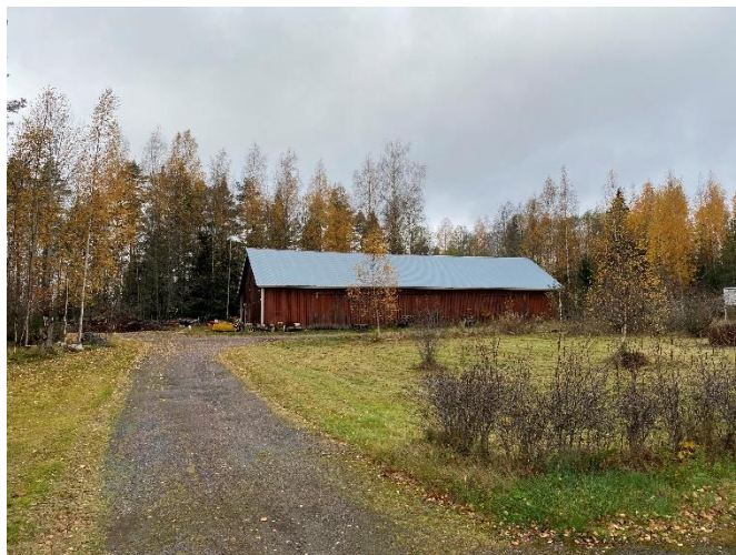
Entisen kunnalliskodin pihapiirissä sijaitseva ulko-/talousrakennus.
