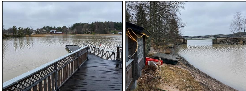
Laituri kiinteistöllä 738-510-1-19 MUUMIMÄKI. Oikealla olevassa kuvassa Rantolansalmen silta (suunnittelualueen ulkopuolella). Merikortin mukainen sillan alituskorkeus on 1,6 m.
