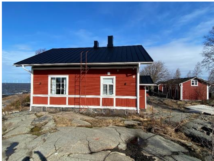
Kuva 18: Luotsivartiotupa sekä pihapiiriin kuuluvia talousrakennuksia.
