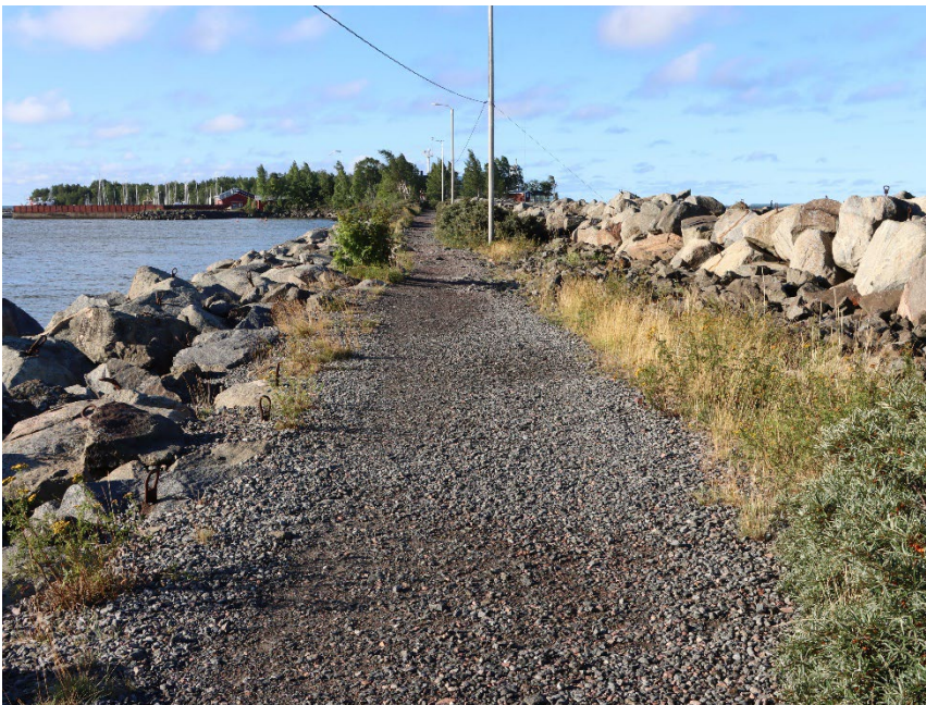
Kuva 5. Aallonmurtaja Kallon pohjoiskärjessä.
