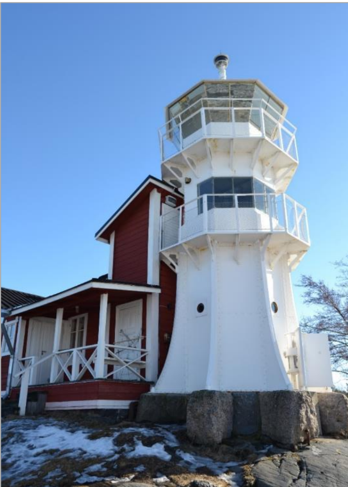
Kuva 26. Majakkatorni on kahdeksankulmainen. Kuvannut KT.
