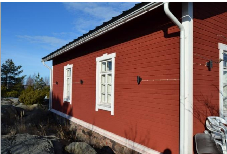
Kuva 36. Luotsivartiotupa kuvattuna länsisivulta. Kuvannut KT.
