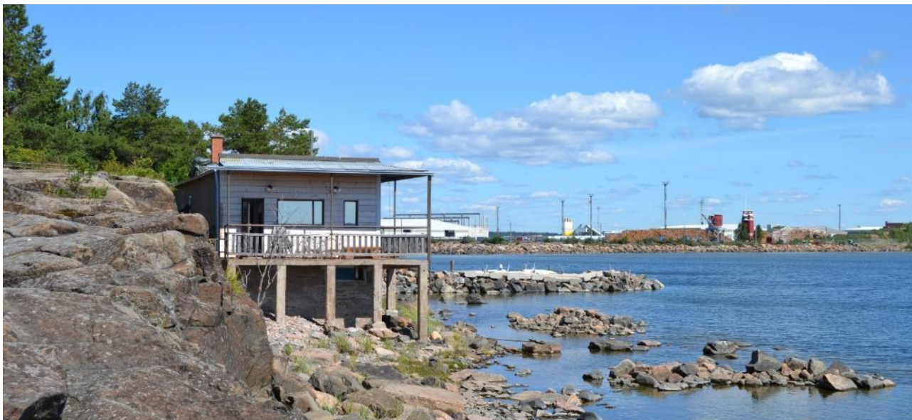
Kuva 48. Entisen öljysataman rakennus kuvattuna etelästä heinäkuussa 2022. Taustalla näkyy Kallon pengertie ja Mäntyluodon satama. Kuvannut KT.
