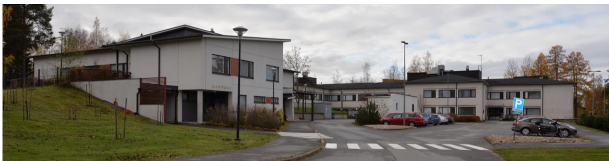
Kuva: Ikaalisten sosiaali- ja terveyskeskus 1981 (rak. ark. Veikko Voutilainen), laajennukset 2000-luvulla, aumakatto 2013.
