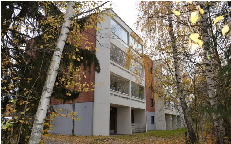
Kuvat: Ojasenkatu 2 Silkintielle ja pihasivu, ja Ojasenkatu 4 julkisivu lounaaseen ja koilliseen sekä pääty 2021,
