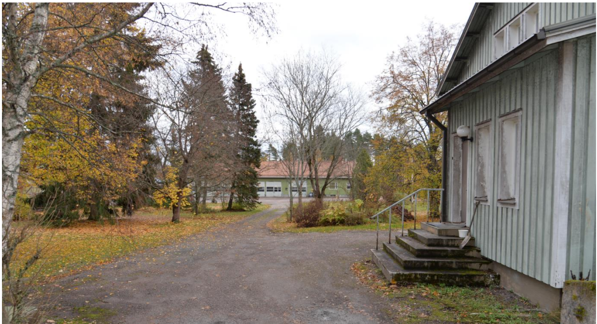
Kuvat: Näkymät Kallintielle ja asuinrakennuksen kulmalta kohti autotalleja. Asuinrakennus on säilyttänyt alkuperäisen aukotuksensa, mutta rakennus on todennäköisesti lisäeristetty: ikkunat eivät sijaitse julkisivun tasossa.
