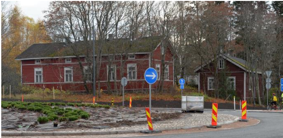
Kuvat: Risteys Silkin- tieltä, Hakumäen asuinrakennukset.
