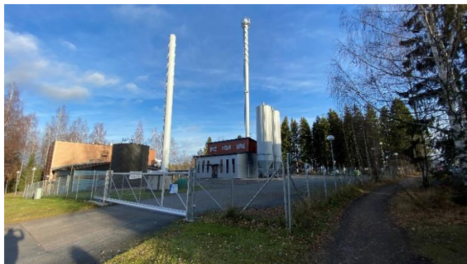
Lämpövoimala korttelin 1 pohjoispuolella suunnittelualueen ulkopuolella.
