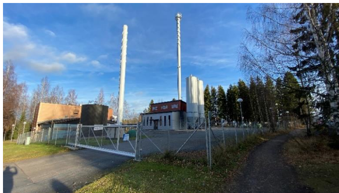
Lämpövoimala korttelin 1 pohjoispuolella suunnittelualueen ulkopuolella.
