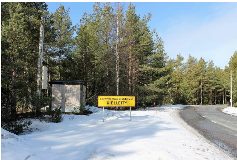
Kuva 14. Muuntamorakennus sijaitsee sisääntulotien läheisyydessä epävirallisen parkkipaikan reunalla.
