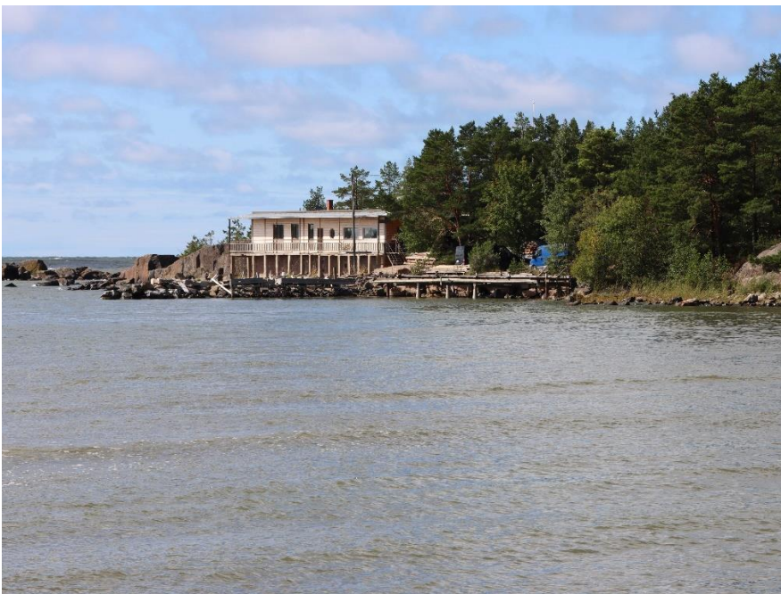
Kuva 10. Rakennus Mäntykallon itärannalla.
