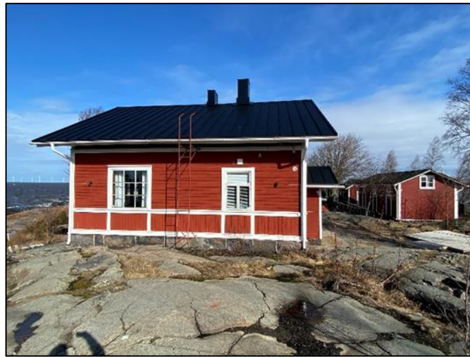
Kuva 20: Luotsivartiotupa sekä pihapiiriin kuuluvia talousrakennuksia.
