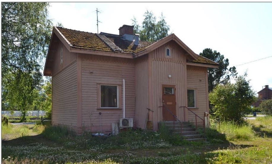
Kuva 35. Kaksoisvahtitupa kuvattuna pihan puolelta. Asemalle johtava tie jää kuvassa rakennuksen taakse.
