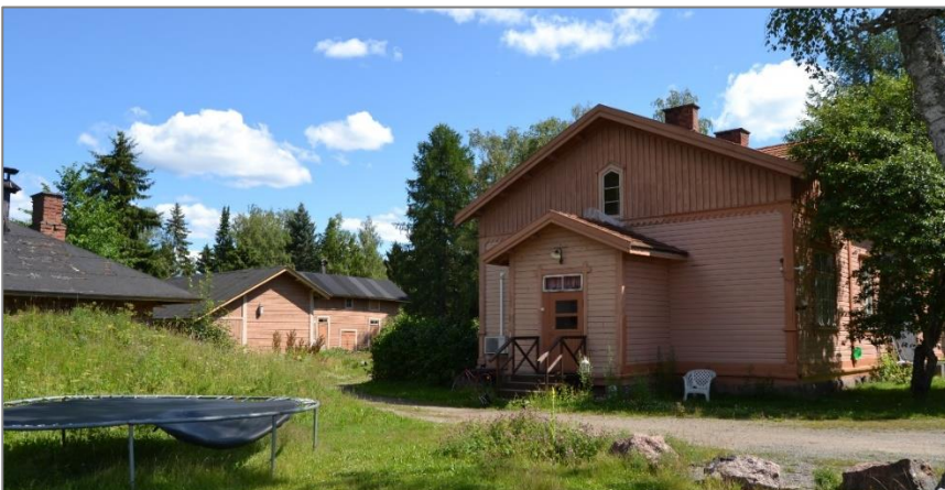
Kuva 27. Asuinrakennuksen pohjoispääty. Kuvan vasemmassa reunassa näkyy isomman kellarin katto, taustalla näkyvät ulkorakennukset.
