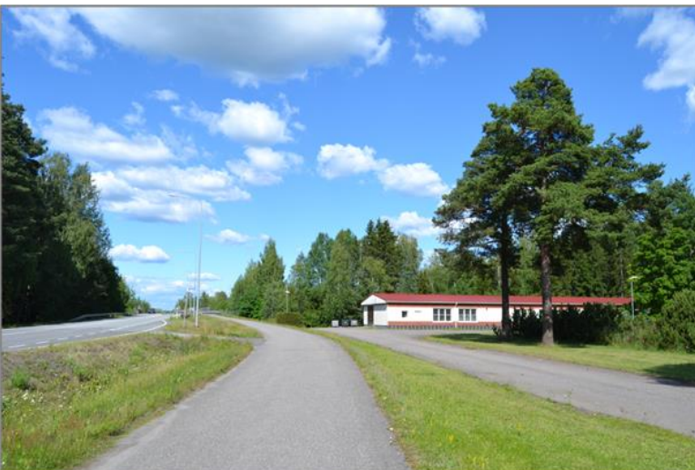
Kuva 64. Kuva Haanmäen alueelta, Satakunnantien varren kevyenliikenteenväylältä pohjoiseen päin, kohti rautatien ylittävää tiesiltaa. Rakennus kuvassa on entinen kenkätehdas.
