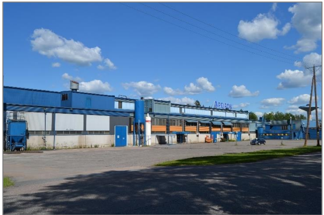
Kuva 8. Selvitysalueen kaakkoisosassa Haanmäellä sijaitsee vaihteittain 1970–1980-lukujen taitteesta lähtien rakentunut Peiron Oy:n tuotantolaitos.
