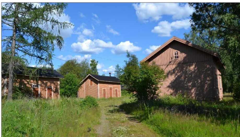
Kuva 37. Kaksoisvahtituvan pihapiiri kuvattuna lounaasta. Asuinrakennus kuvassa oikealla.
