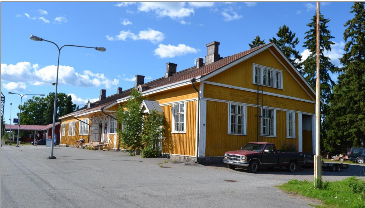
Kuva 47. Asemarakennuksen radan puolen pääjulkisivu ja itäpäätty.
