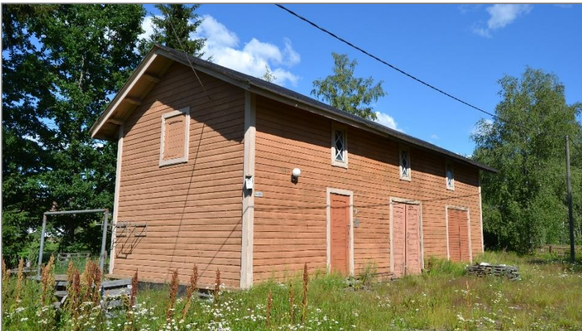
Kuva 41. Asemapäällikön talon ulkorakennus kuvattuna lännen suunnasta.
