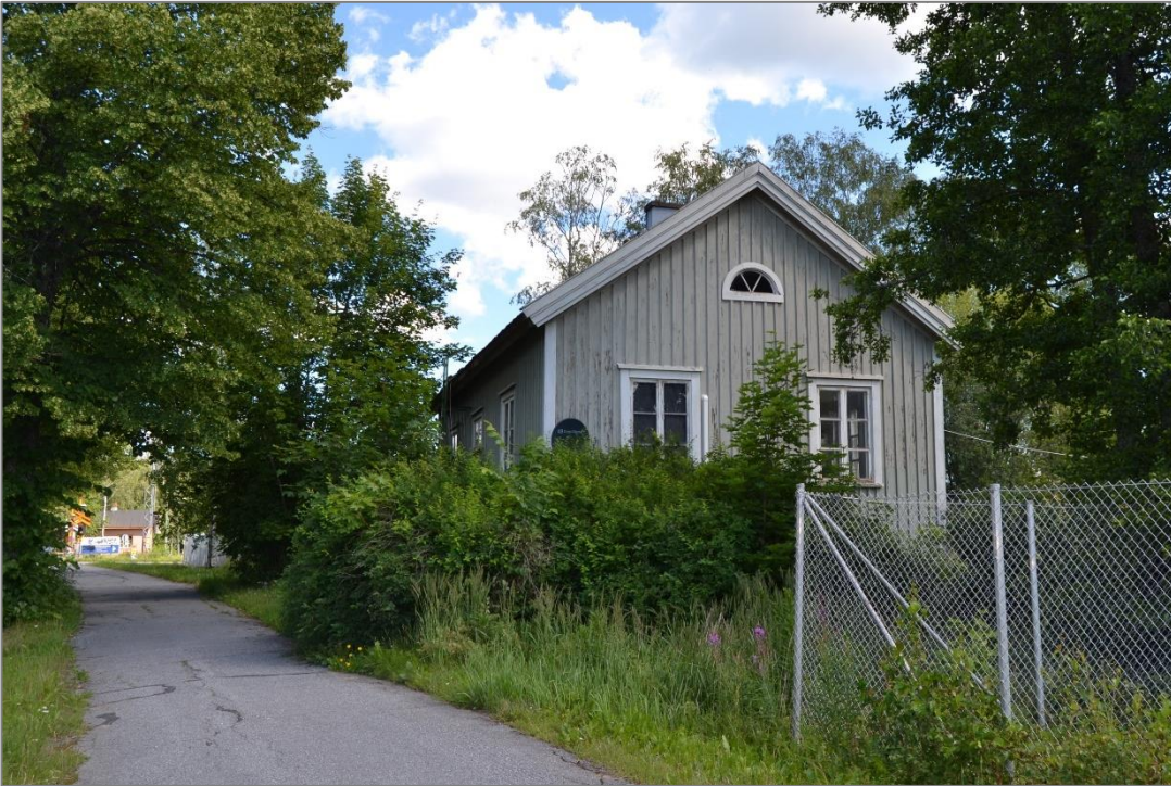
Kuva 16. Ratamestarin asuintalon eteläpääty kuvattuna heinäkuussa 2023.
