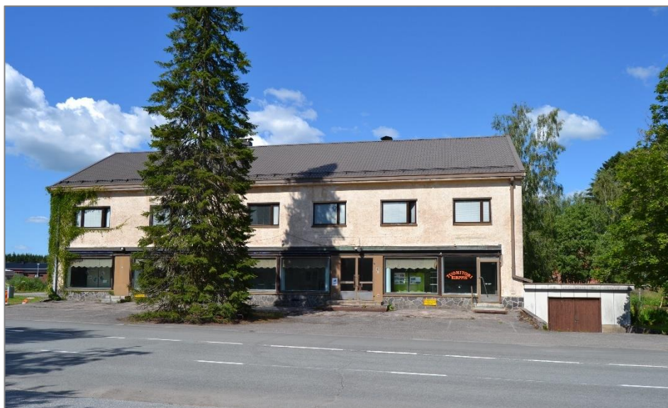
Kuva 56. Tiensivun kiinteistön itäsivu kuvattuna Köyliöntien yli. Rakennuksen edessä kasvaa korkea kuusi.
