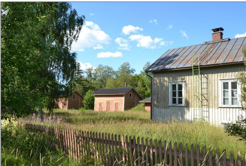
Kuva 13. Kuva Asemakujalta pohjoiseen. Etualalla kirjurin asunto, taustalla kaksoisvahtituvan pihapiirin ulkorakennuksia.
