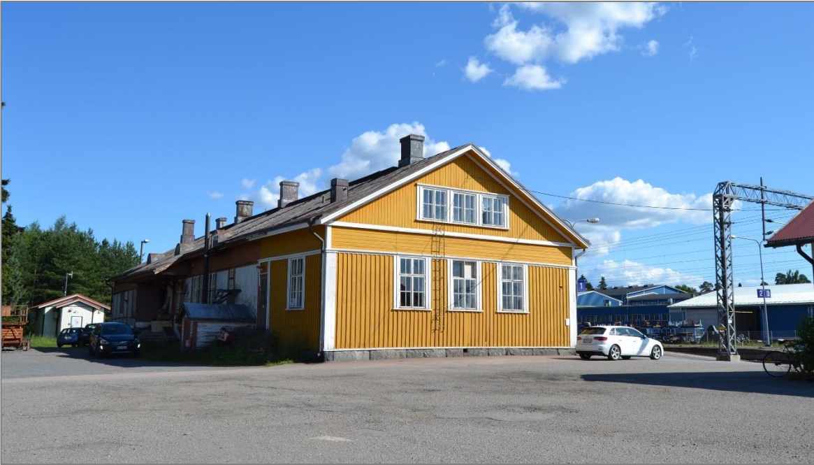
Kuva 46. Asemarakennus kuvattuna luoteiskulmalta.
