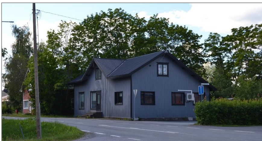
Kuva 50. Entinen kauppakiinteistö kuvattuna koilliskulmalta Köyliöntien yli.
