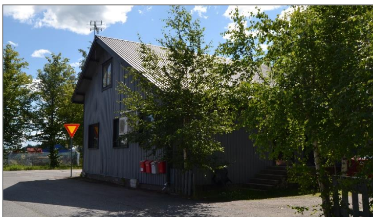
Kuva 51. Rakennuksen pohjoispääty ja länsisivu kuvattuna Liikkiöntieltä.
