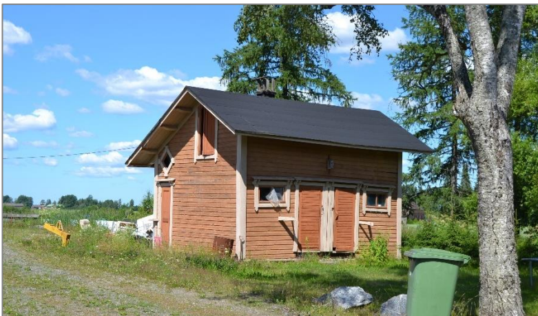
Kuva 22. Veturitallien ulkorakennus kuvattuna kaakosta.
