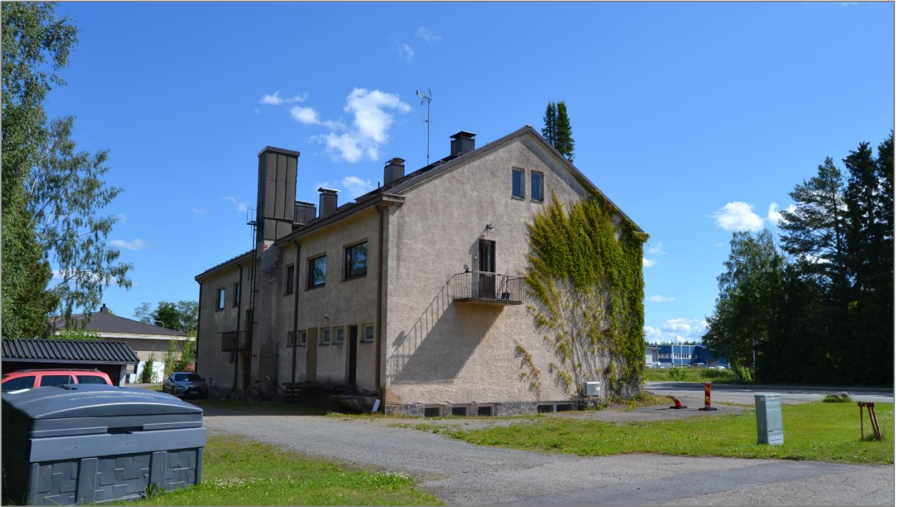
Kuva 57. Rakennuksen eteläpääty ja länsisivua.
