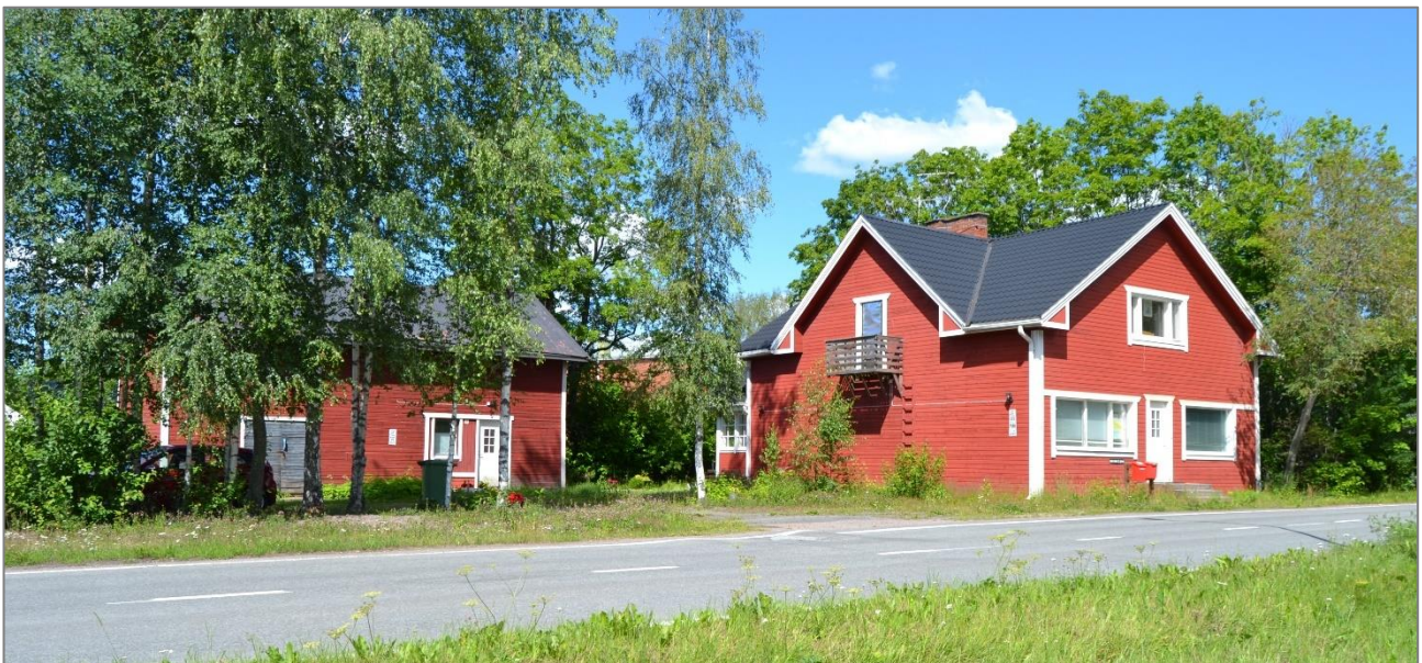
Kuva 52. Sampolan kiinteistö kuvattuna Köyliöntien yli. Oikealla entinen myymälä, vasemmalla makasiinirakennus.
