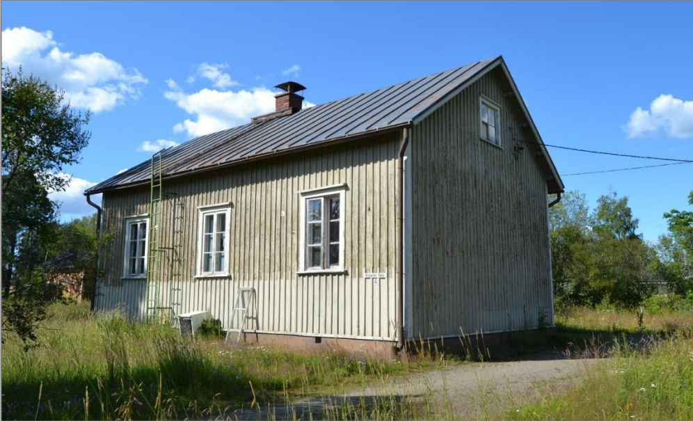
Kuva 39. Kirjurin asuintalo kuvattuna etelän suunnasta Asemakujalta.
