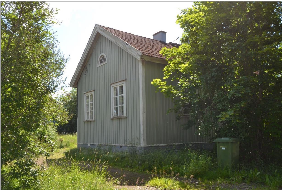
Kuva 17. Ratamestarin asuintalon pohjoispääty ja länsisivua kuvattuna Köyliöntien varren kevyenliikenteenväylältä.
