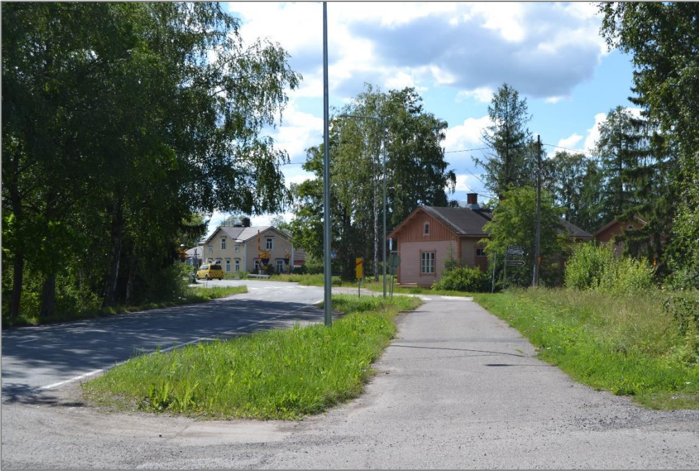
Kuva 66. Näkymä Köyliöntien varrelta kohti Peipohjan tasoristeystä. Kuvaussuunta lounaaseen.
