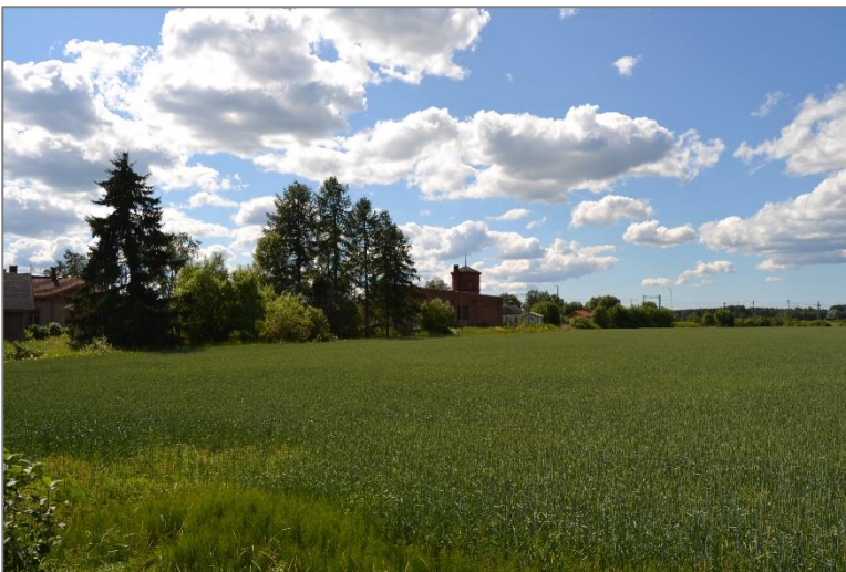
Kuva 65. Selvitysalueen länsipuolella avautuu Peipohjan peltoaukea. Kuvan keskivaiheilla näkyy veturitallin rakennus, ja sen vasemmalla puolella VR:n asuinrakennusten pihapiiriä. Kuva on otettu Opistontieltä länteen päin.
