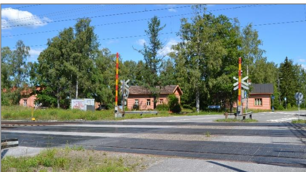
Kuva 6. VR:n asuinrakennuksia ja sauna-pakari kuvattuna tasoristeuksen yli, kuvaussuunta pohjoiseen.
