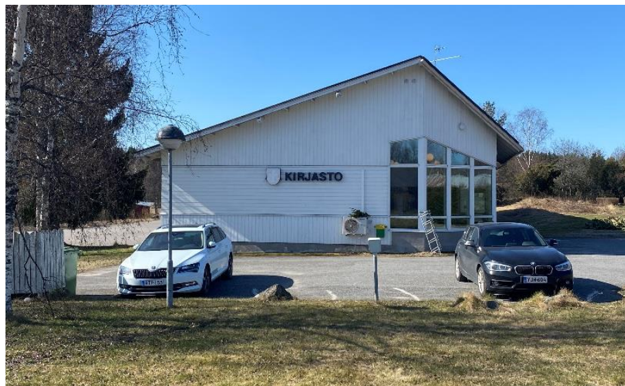
Kirjasto/paloasemarakennus korttelissa 1b kuvattuna koillisesta.
