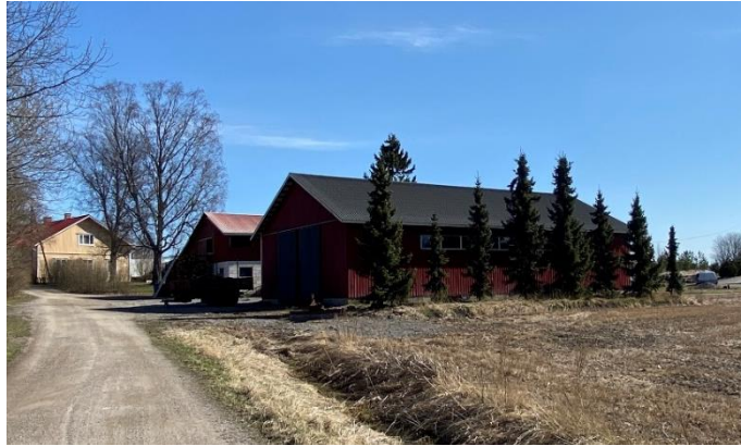
Kuva lounaasta valtatieltä 8 kohti Ihoden Kylätietä. Kuvassa korttelin 40 rakennuksia.
