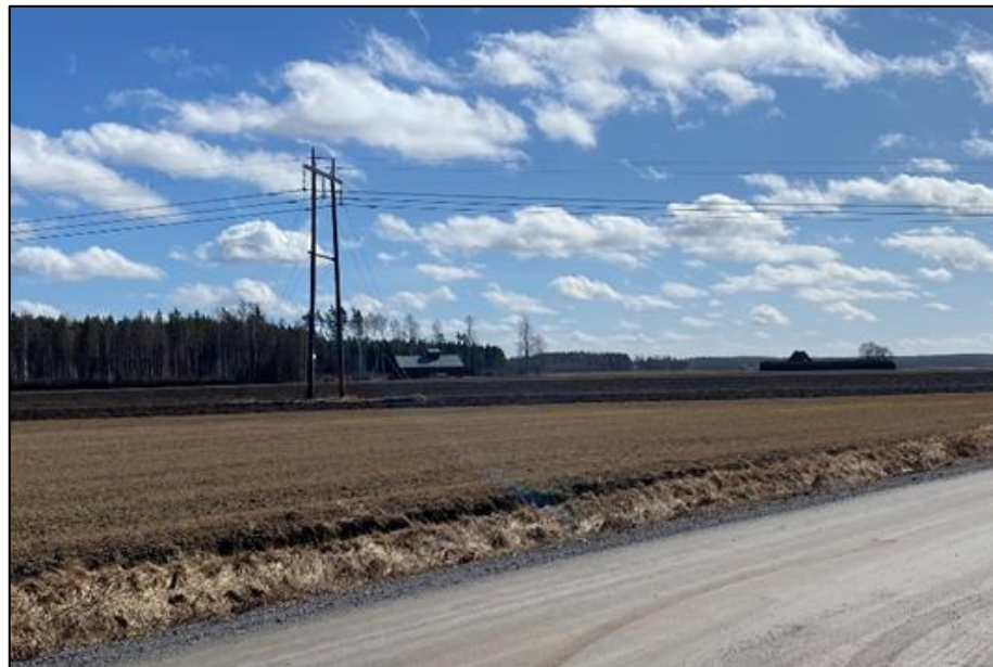
Peltoalueen reunalla kiinteistöllä 531-414-1-85 sijaitseva talousrakennus sekä suunnittelualueen lounais-koillissuunnassa halkova Fingridin 110 kV voimalinja suunnittelualueen lounaispuolelta kuvattuna.
