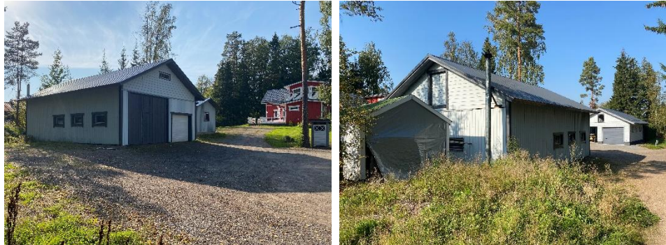
Rakennuksia suunnittelualueen kiinteistöillä 581-4-4025-13 ja 581-4-4025-14.
