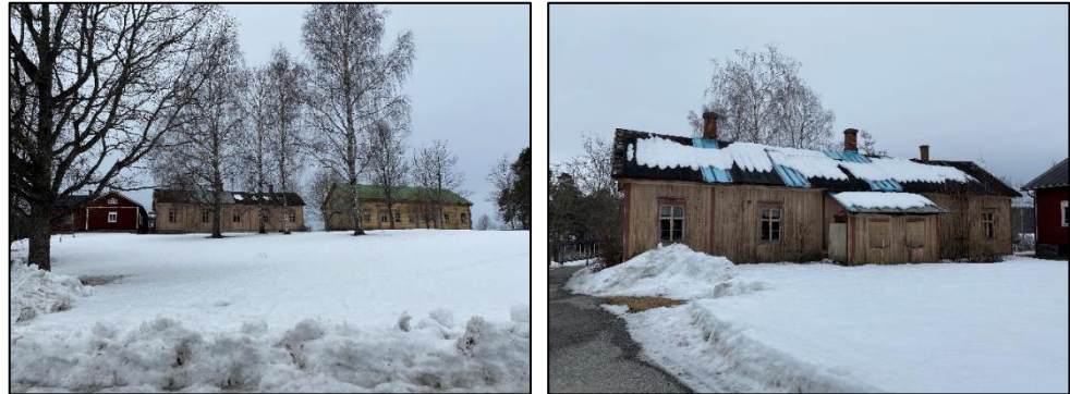
Tuomarlan tilan vanhoja rakennuksia. Oikeassa kuvassa käytöstä poistunut rakennus.
