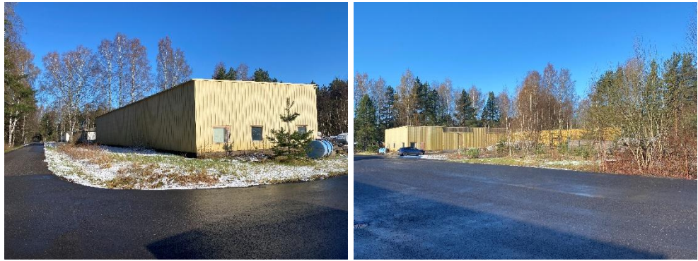
Teollisuusrakennuksia suunnittelualan kiinteistöllä 783-401-58-4 TEOLLISUUS-TIE III.
