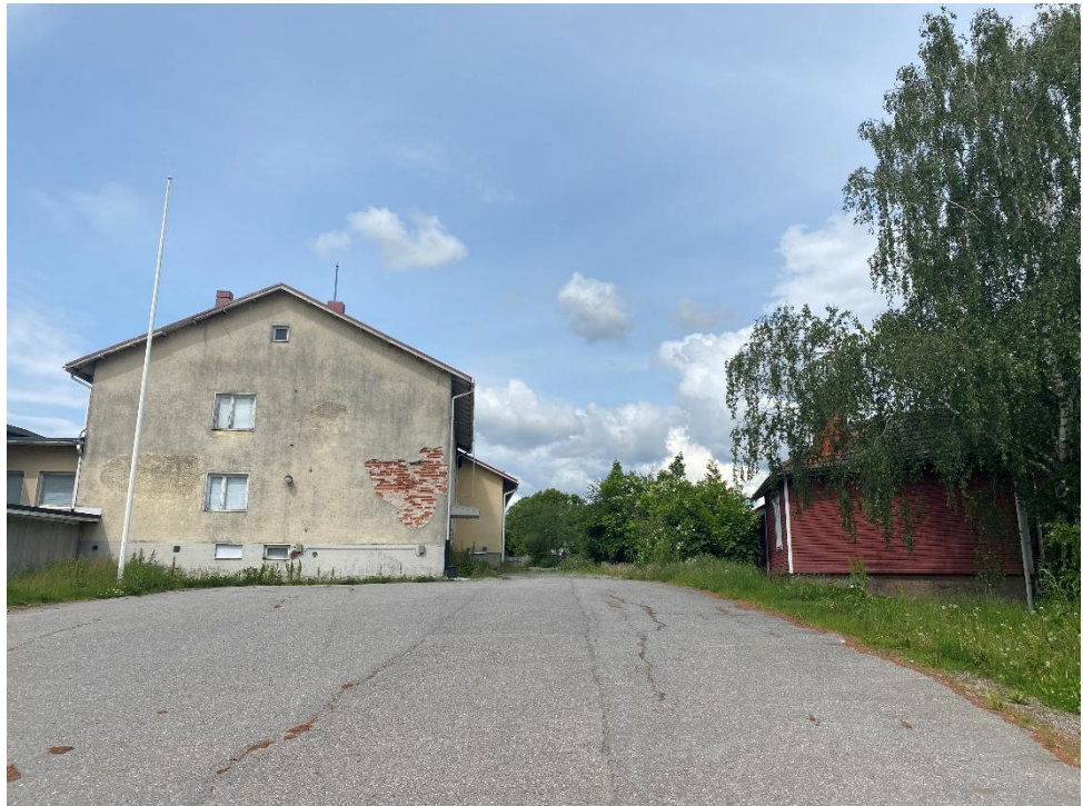
Kallipään torppa (punainen rakennus) Nummen koulun pysäköintialueelta kuvattuna.
