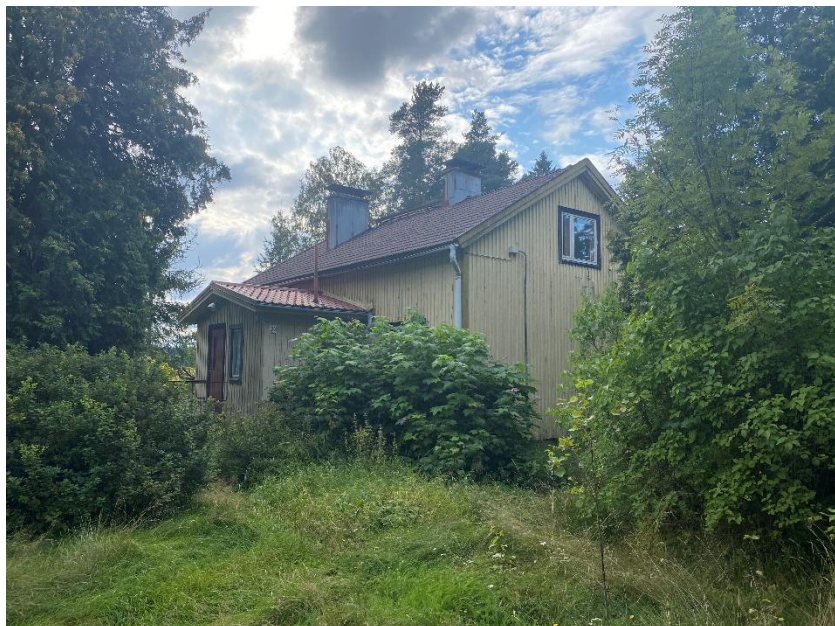
Kuva suunnittelualueen pohjoisosassa olevasta omakotitalosta, joka on purettu kaavaprosessin aikana
