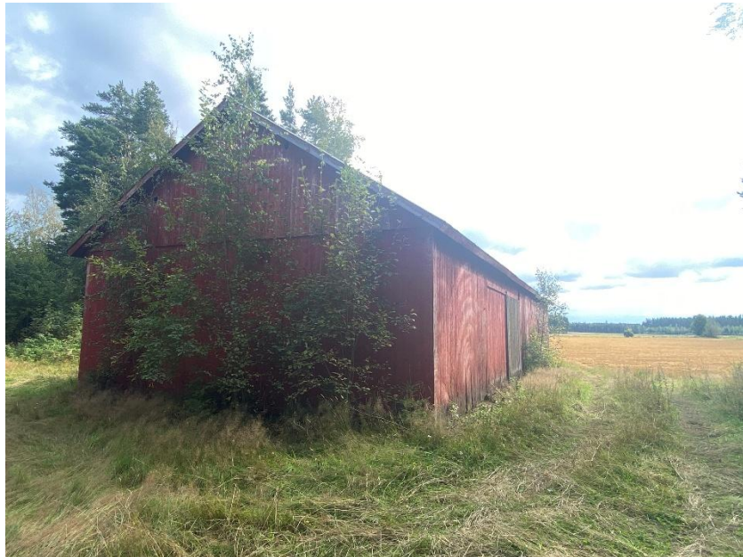
Kuva suunnittelualan pohjoisosan talouskeskuksen talousrakennuksesta, joka on purettu kaavaprosessin aikana
