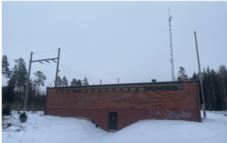
Sähköasema, jonka taustalla sähköaseman eteläpuolella sijaitseva telemasto.
