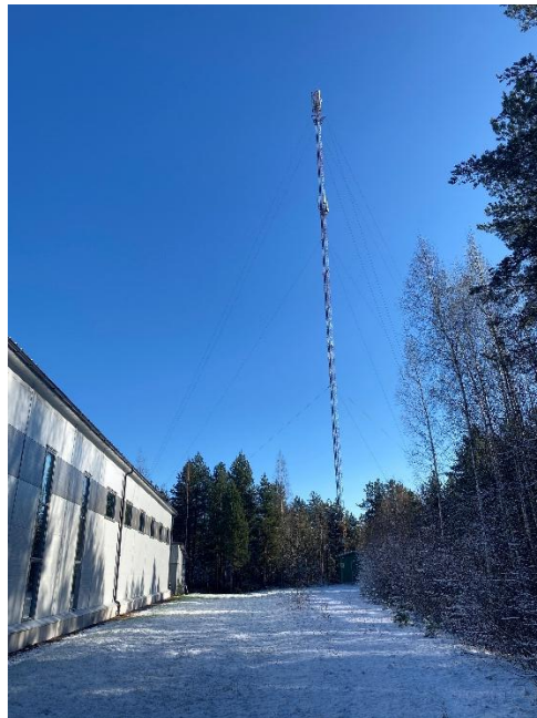
Suunnittelualueella sijaitsee radiomasto ja laitesuoja.
