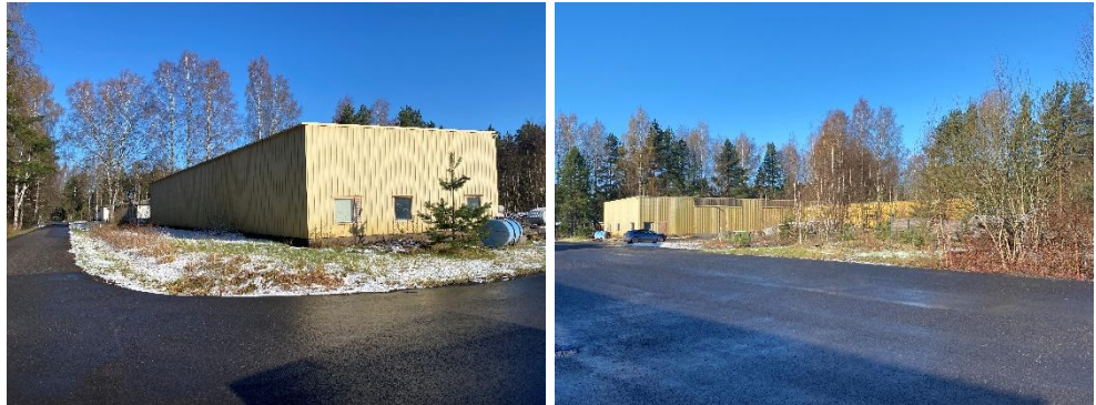
Teollisuusrakennuksia suunnittelualueen kiinteistöllä 783-401-58-4 TEOLLISUUS-TIE III.
