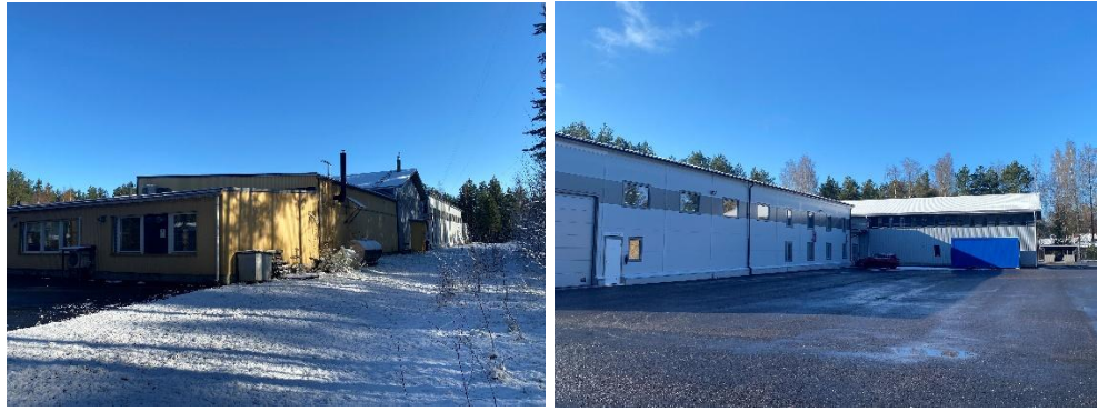
Teollisuusrakennuksia suunnittelualueen kiinteistöllä 783-401-58-25 Jarila.
