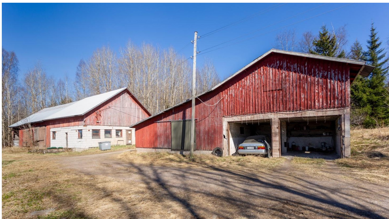
Kuva 30. Lähteenmäen tilan talli/kuivurirakennus.
