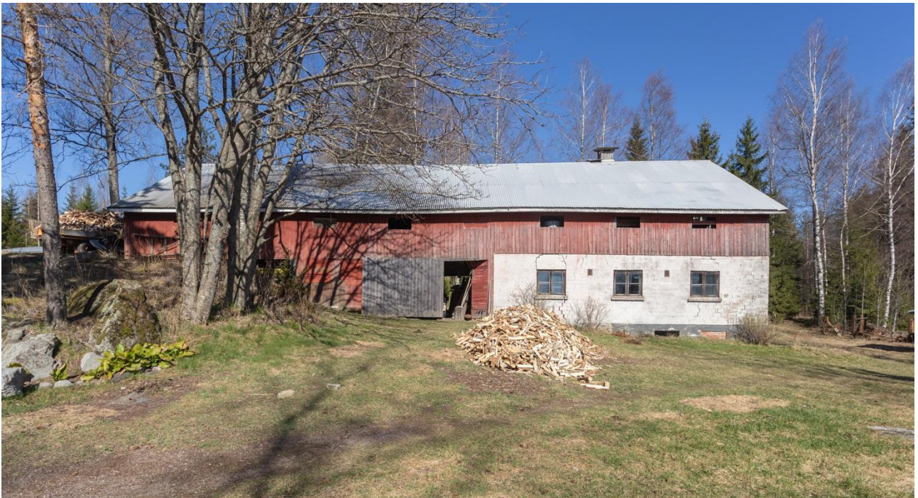
Kuva 18. Pajamäen navetta. Kuvaussuunta koilliseen.
