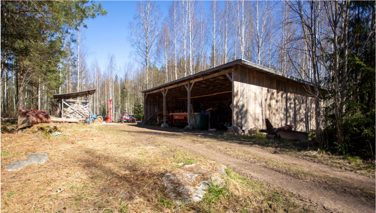
Kuva 21. Pihan perillä sijaitseva konesuoja. Kuvaussuunta koilliseen.
