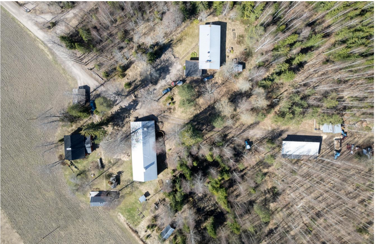
Kuva 12. Drone-kuva Pajamäestä, pihapiirin päältä.
