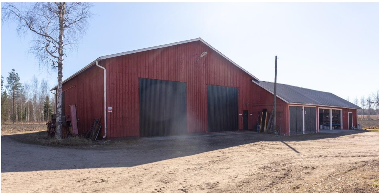
Kuva 44. Alkuperäinen tallirakennus on saanut jatkoa kookkaammasta konesuojasta. Kuvaussuunta etelään.
