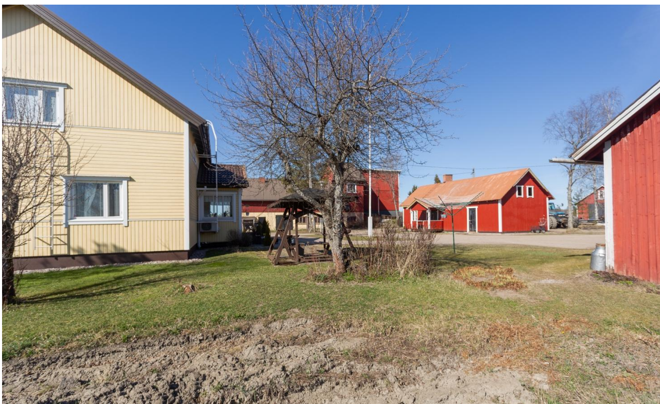
Kuva 36. Huhtamäen pihapiiriä päärakennuksen ja tallin kulmilta. Kuvaussuunta koilliseen.
