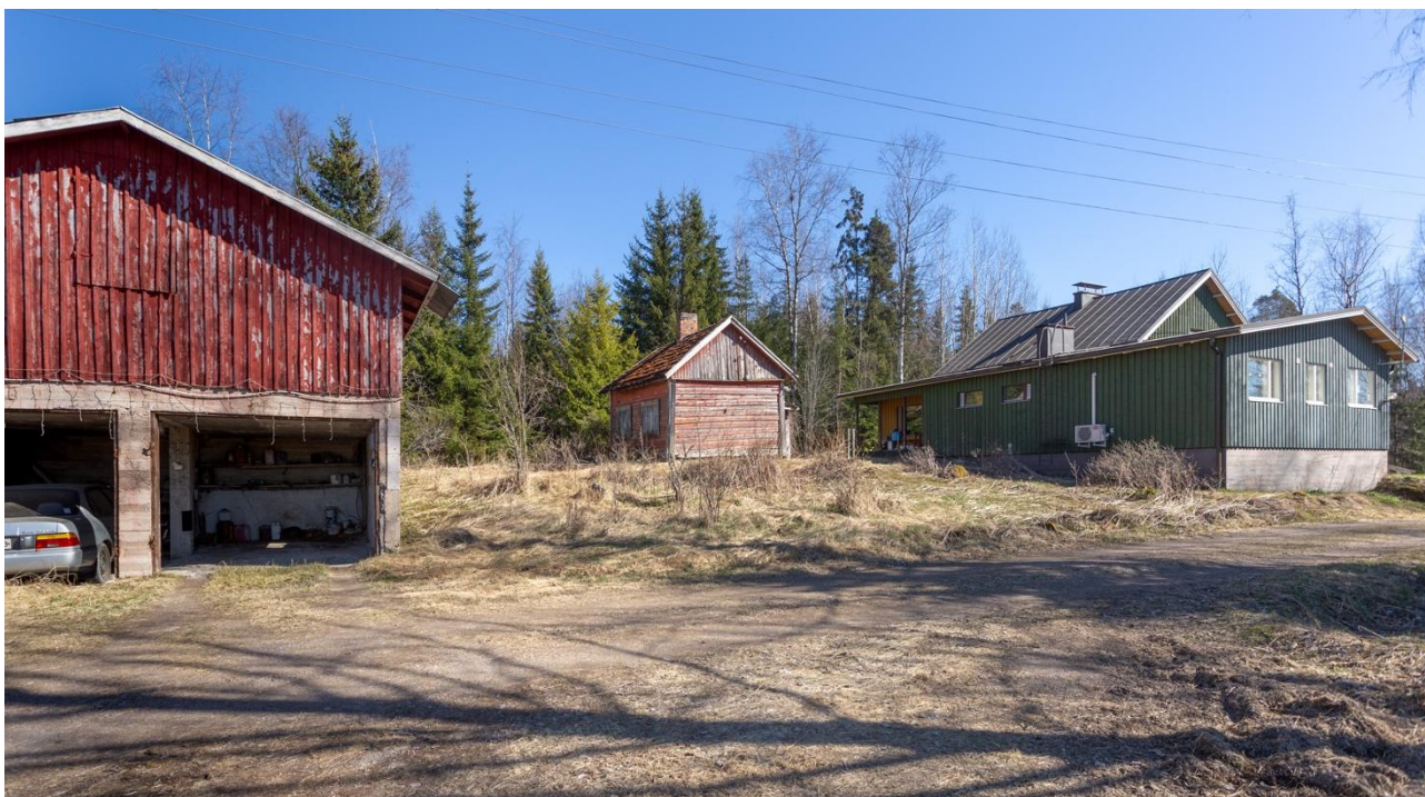
Kuva 26. Lähteenmäen tilaa: talli, mökki ja päärakennus lisäsiipineen. Kuvaussuunta kaakkoon.
