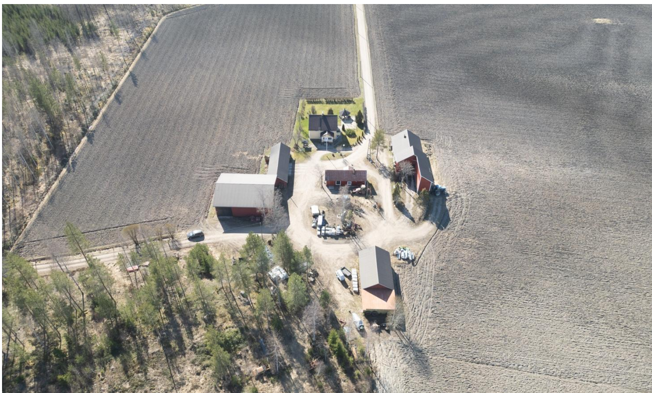
Kuva 33. Huhtamäen pihapiiriä dronella kuvattuna. Kuvaussuunta länteen.
