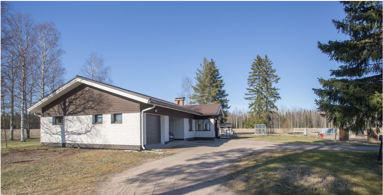
Kuva 63. Koivulehdon päärakennus. Kuvaussuunta pohjoiseen.
