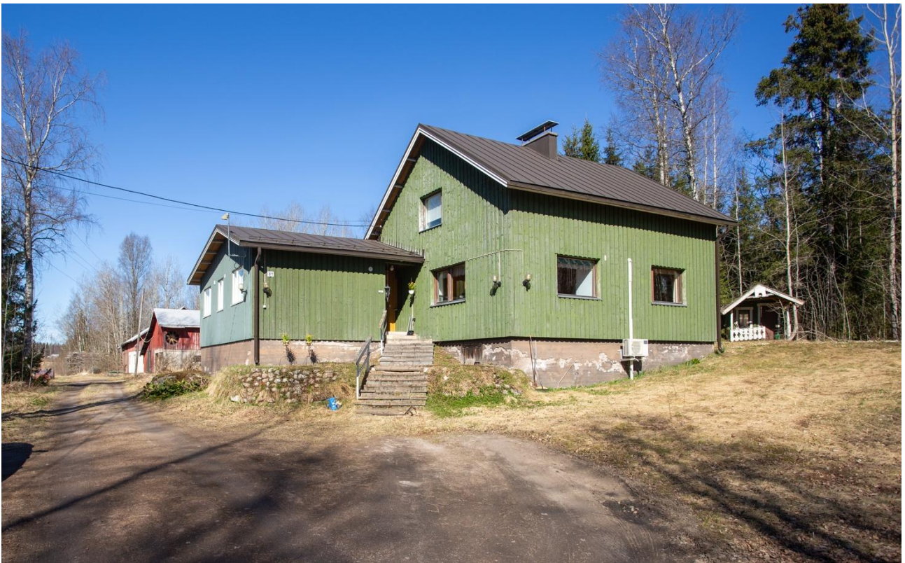
Kuva 27. Lähteenmäen päärakennus. Kuvaussuunta koilliseen.
