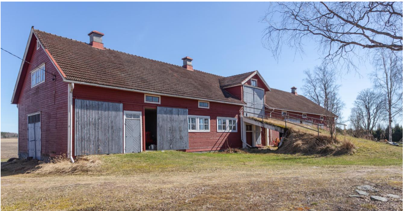
Kuva 8. Uudenkartanon navetan pääjulkisivu. Kuvaussuunta kaakkoon.
