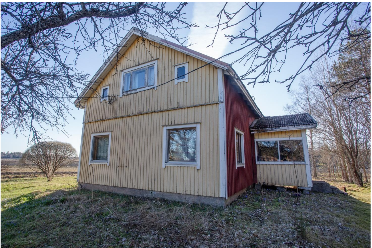
Kuva 73. Piurun päärakennus. Kuvaussuunta lounaaseen.
