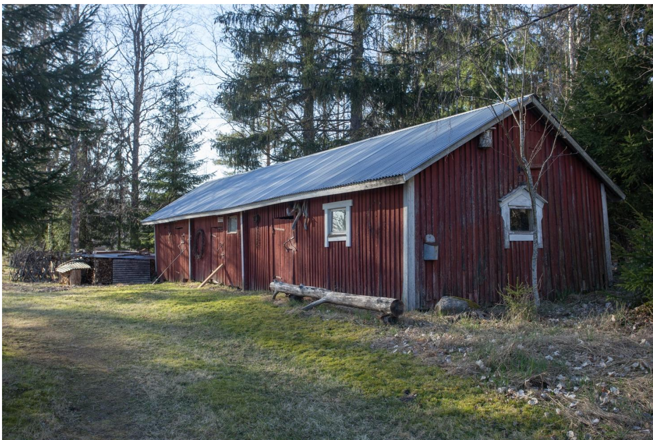
Kuva 75. Piurun vanha navetta. Kuvaussuunta luoteeseen.
