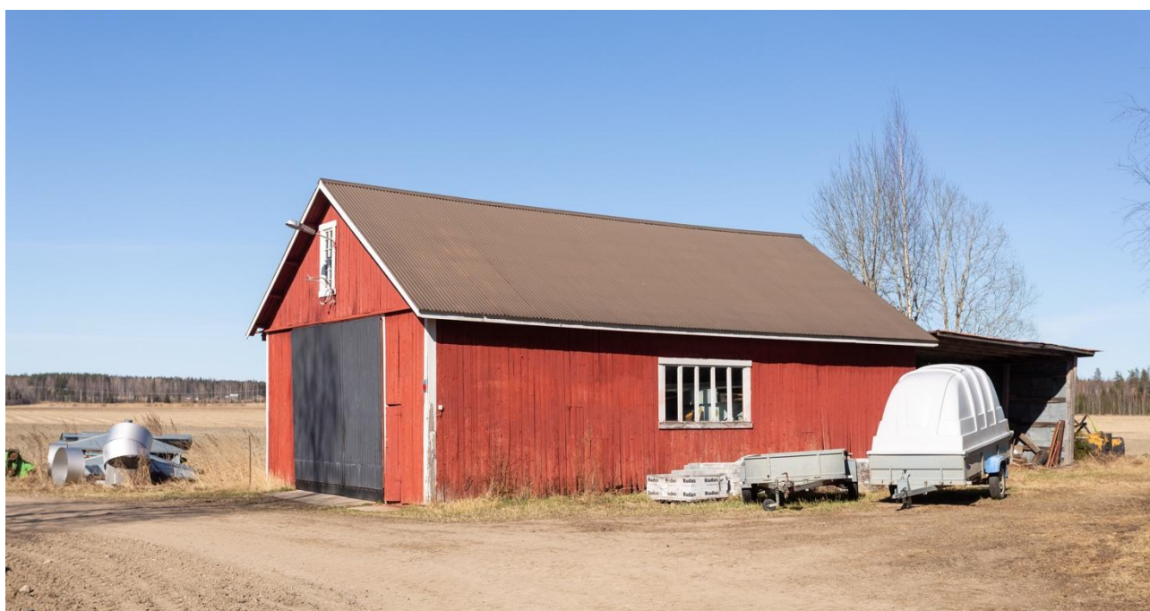
Kuva 45. Ilmakuvista päätellen pihan takaosassa sijaitseva varastorakennus on 1940-luvulta. Kuvaussuunta pohjoiseen.
