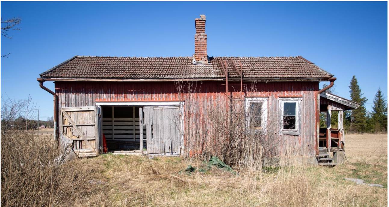
Kuva 10. Uudenkartanon pihapiiristä hieman sivussa sijaitsevan tallin / asuinrakennuksen pääjulkisivu. Kuvaussuunta pohjoiseen.
