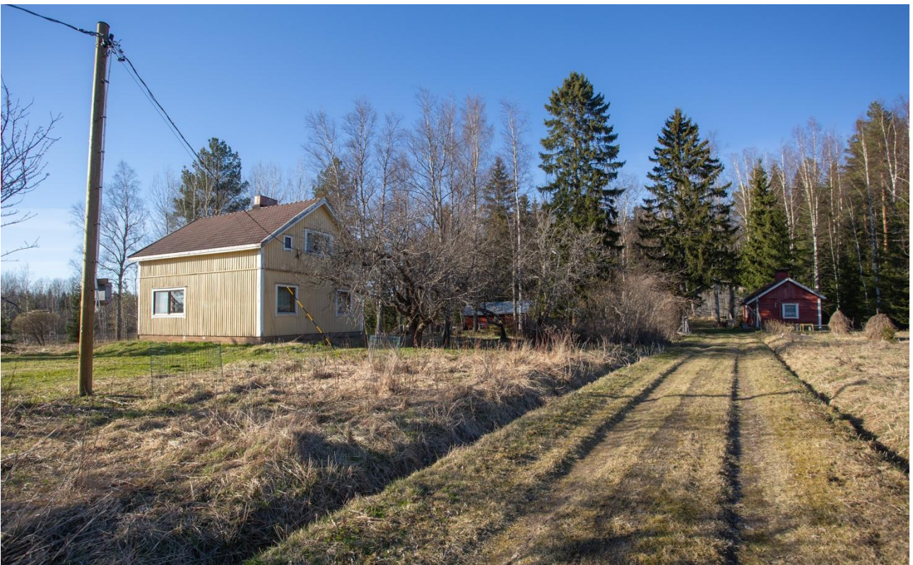
Kuva 71. Piurua Peltomaantieltä saavuttaessa. Etualalla päärakennus. Kuvaussuunta pohjoiseen.
