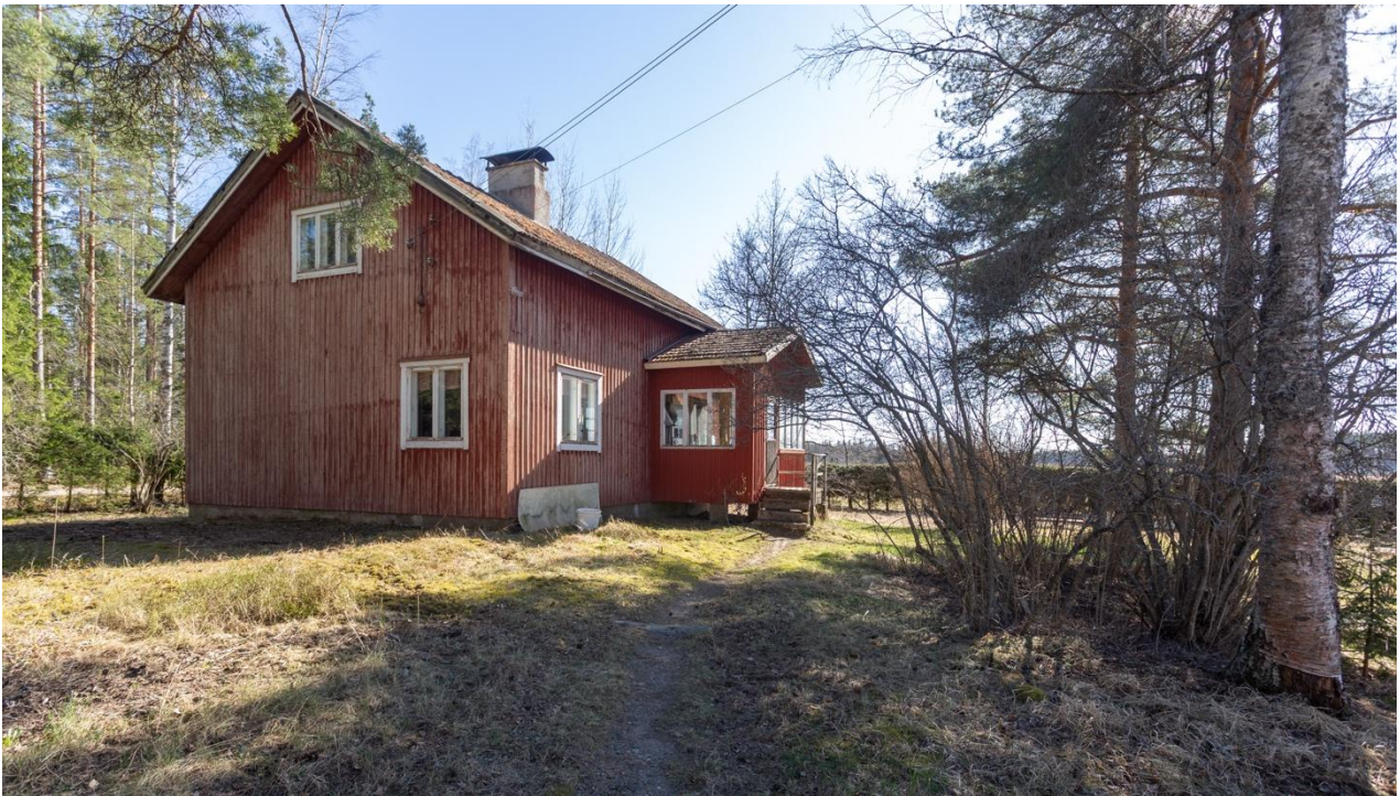
Kuva 54. Ristolan päärakennus. Kuvaussuunta etelään.
