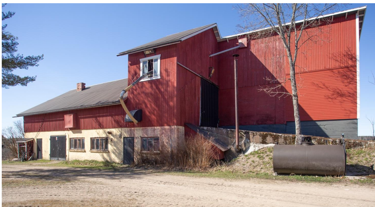
Kuva 43. Hiekkatiillistä navettarakennusta lienee myöhemmin täydennetty kuivurilla. Kuvaussuunta luoteeseen.
