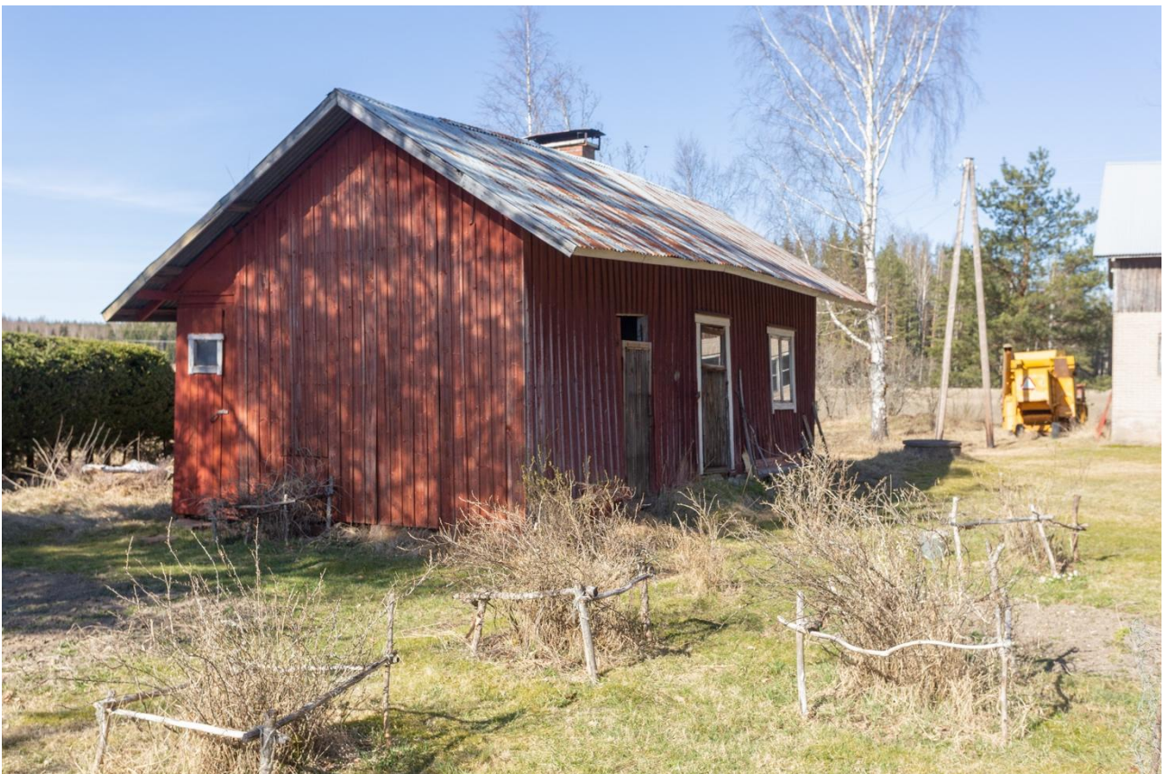
Kuva 55. Ristolan pihapiiriin kuuluva sauna. Kuvaussuunta pohjoiseen.
