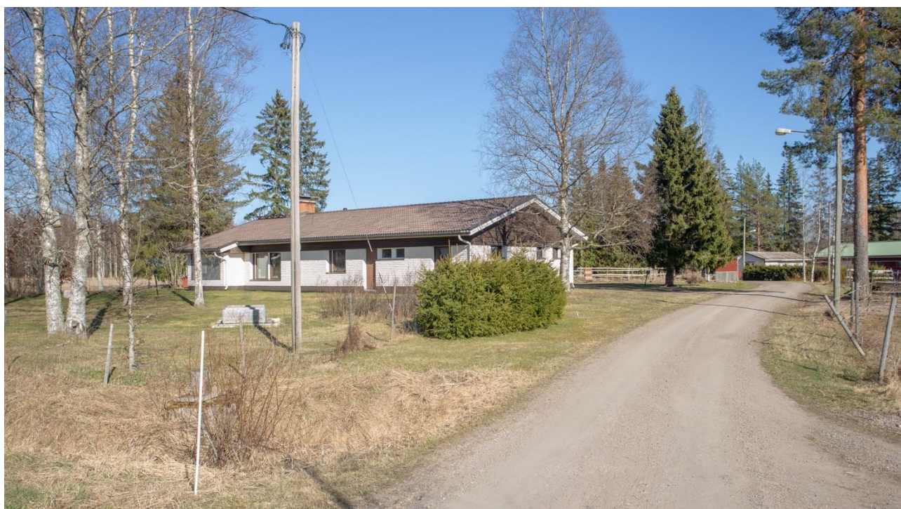
Kuva 62. Näkymä Koivulehdosta Perälähteentietä pitkin, päärakennuksen ohi. Kuvaussuunta itään.
