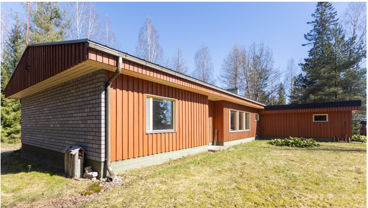
Kuva 18. Kuusiahon kiinteistön omakotitalorakennus. Kuvaussuunta kaakkoon.
