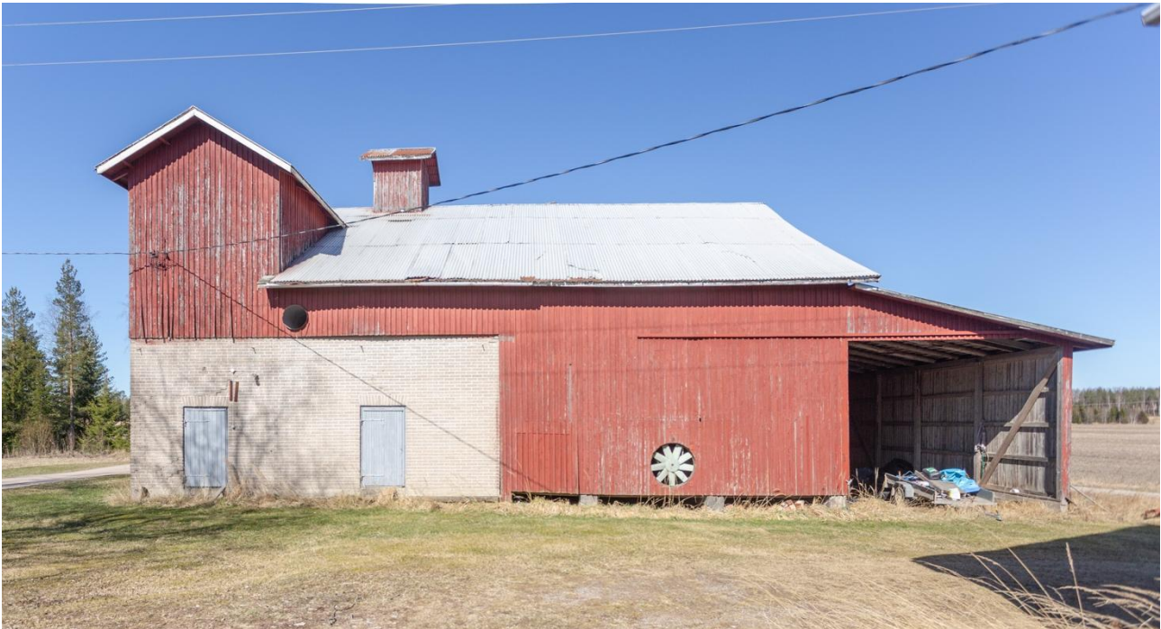
Kuva 9. Uudenkartanon kuivurirakennus ja konesuoja. Kuvakulma pihapiiristä pohjoiseen.
