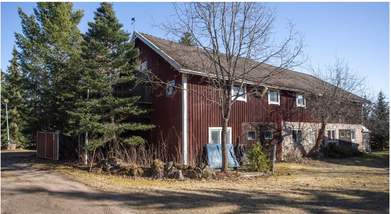
Kuva 68. Perälähteen tilan navetta. Kuvaussuunta etelään.
