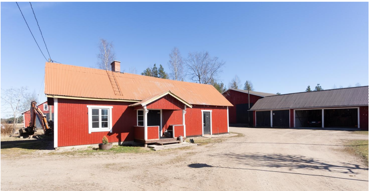
Kuva 42. Huhtamäen pihapiiriin kuuluva sauna/asuinrakennus. Kuvaussuunta itään.
