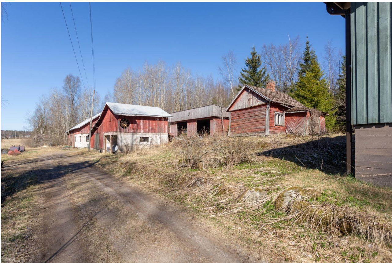
Kuva 25. Lähteenmäen tila päärakennuksen nurkalta. Kuvaussuunta koilliseen.
