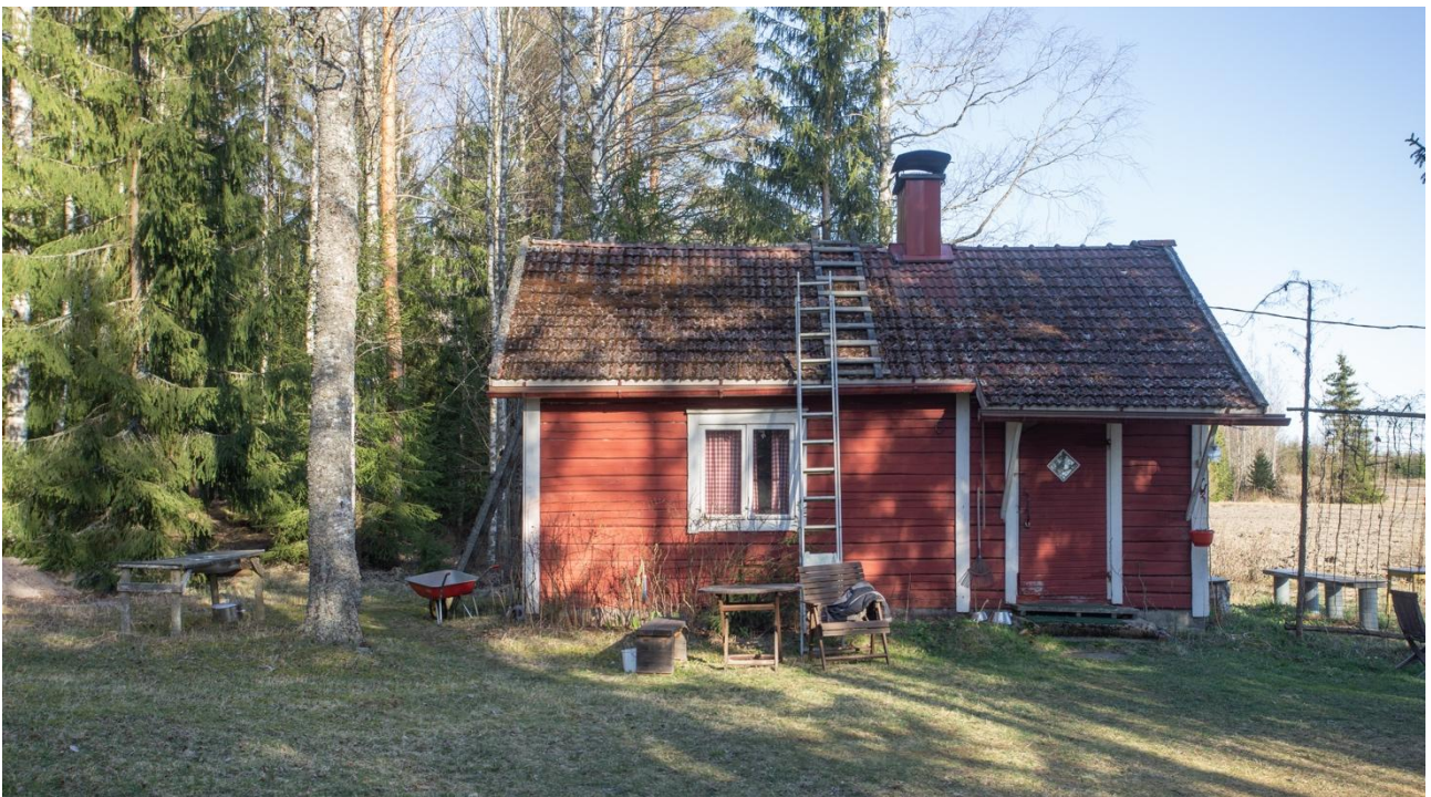
Kuva 74. Piurun sauna. Kuvaussuunta itään.
