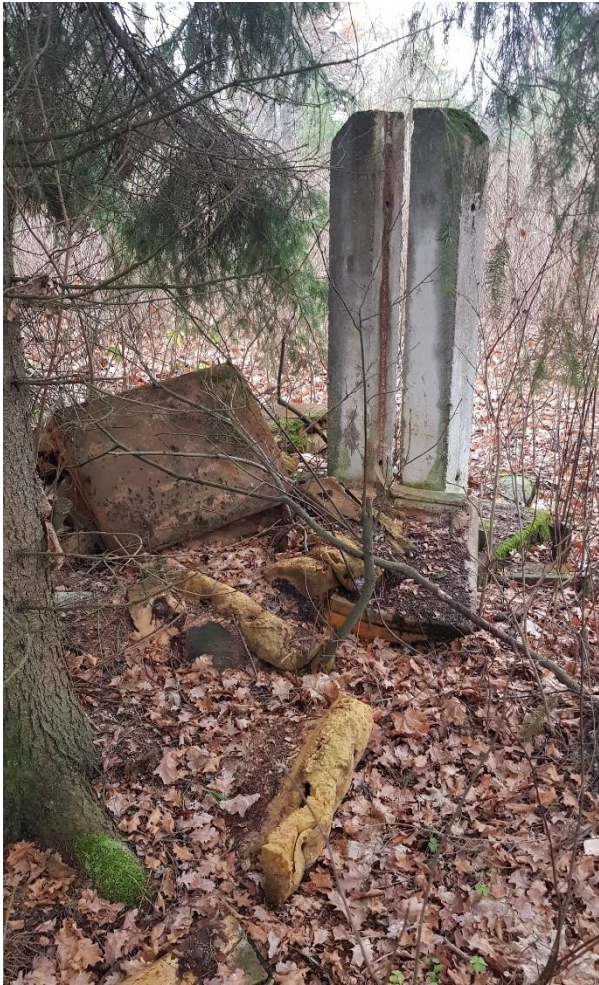
Kuva 6. Kivijalan 2 lähellä sijaitsee vanha lipputangon jalka ja rakennuksesta jäänyttä roskaa.
