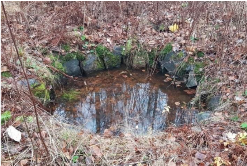
Kuva 3. Toinen kaivoista sijaitsee auton tonttimaan pohjoispuolella.
