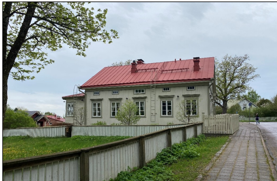
Asuinrakennus suunnittelualueen tontilla 3, joka on voimassa olevassa asemakaavassa osoitettu suojeltavaksi rakennukseksi merkinnällä sr-14. Tennbyntie kuvassa oikealla.
