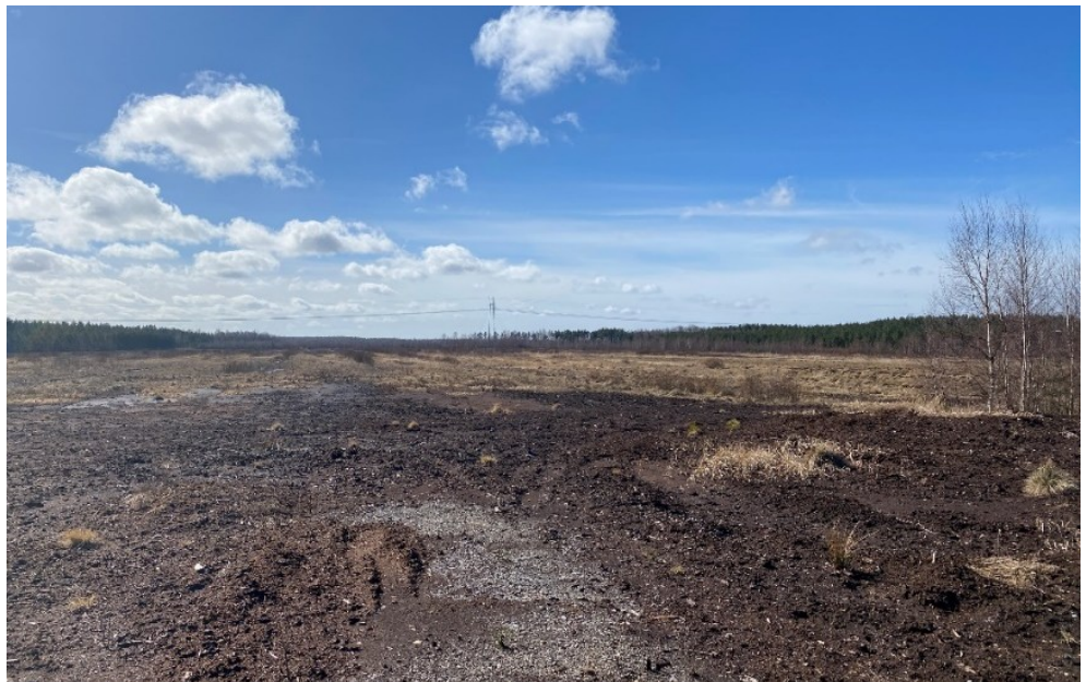
Kuva 5: Kuva suunnittelualueen pohjoisosasta kaakkoon, jossa taustalla näkyy lounais-koillissuunnassa kulkeva Fingridin 110 kV johtolinja.
